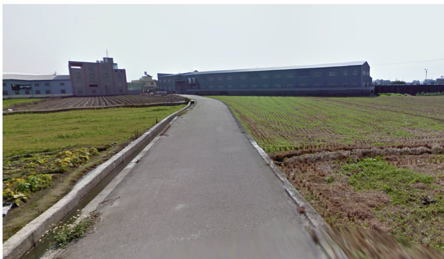
圖 3-20 臺中市后里區起降場地(12/3)作業情形
