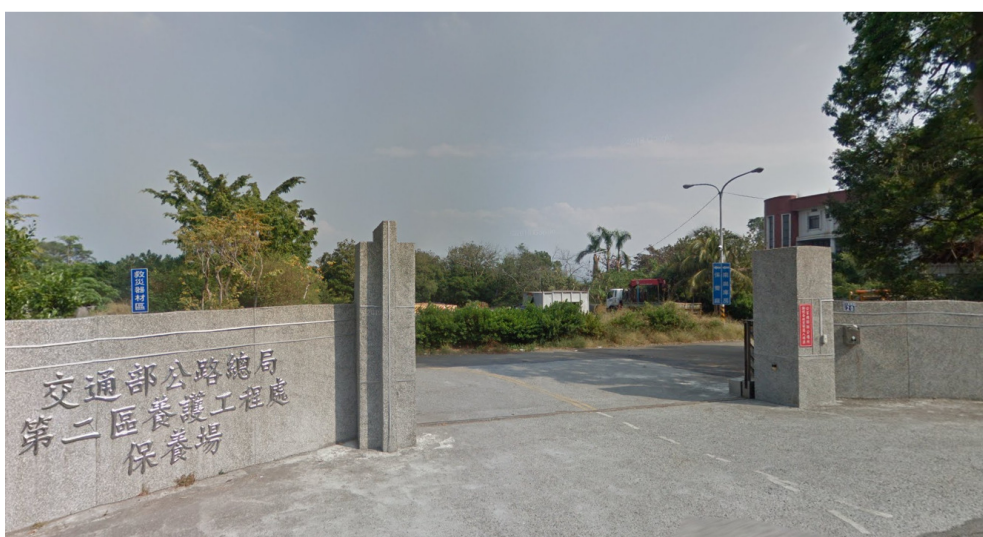
圖 4-20 南崗校正場起降場地作業情形
