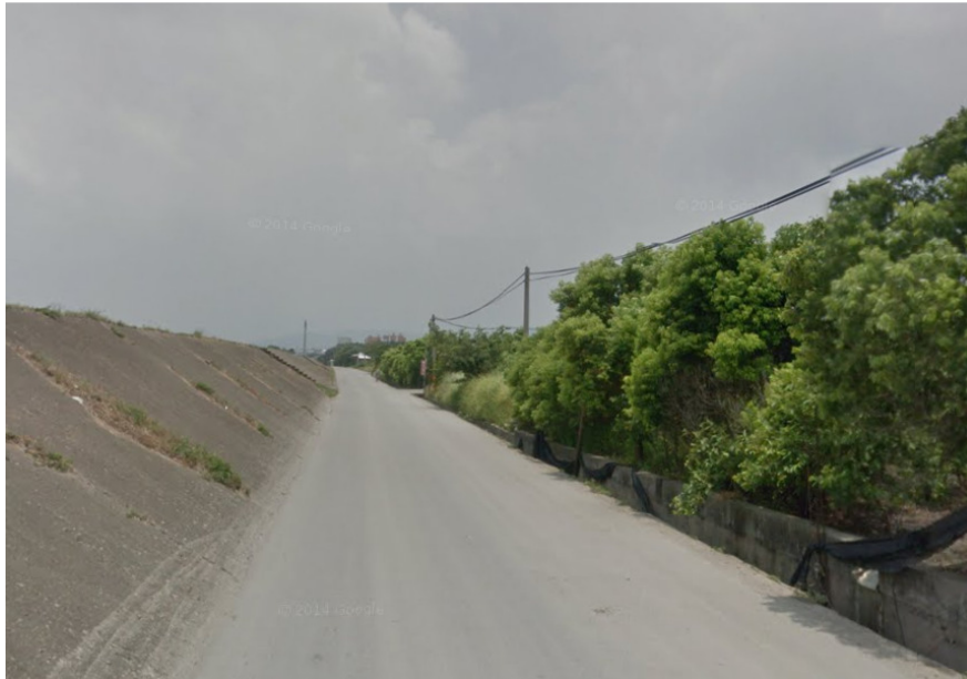
圖 3-19 臺中市后里區起降場地(11/28)作業情形
