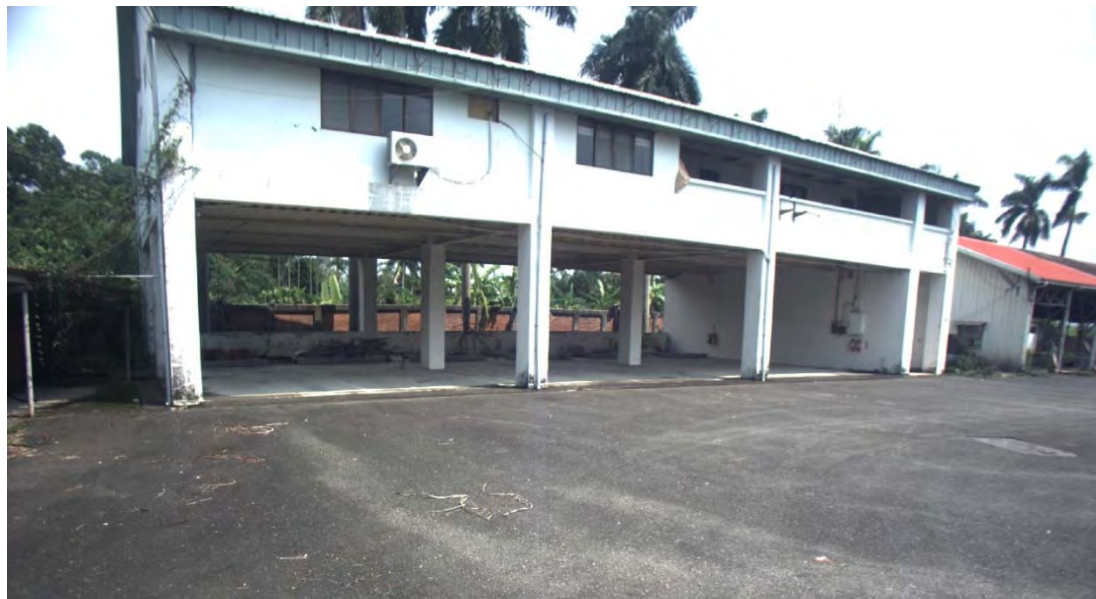
圖 3-76 中興新村高等研究園區(工管組)現場拍攝情形 2
