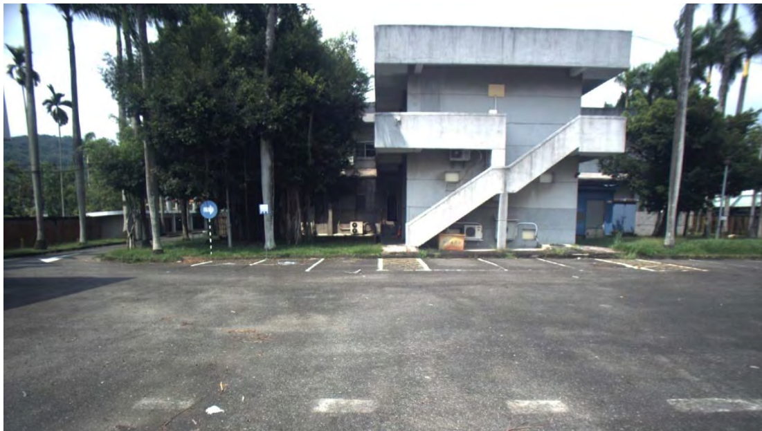
圖 3-75 中興新村高等研究園區(工管組)現場拍攝情形 1
