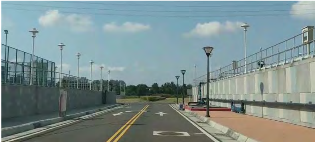
圖 3-56 文山水資源回收中心現場拍攝情形 1
