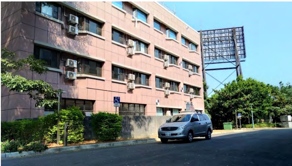
圖 3-89 國土測繪中心車載光達系統檢核作業情形
