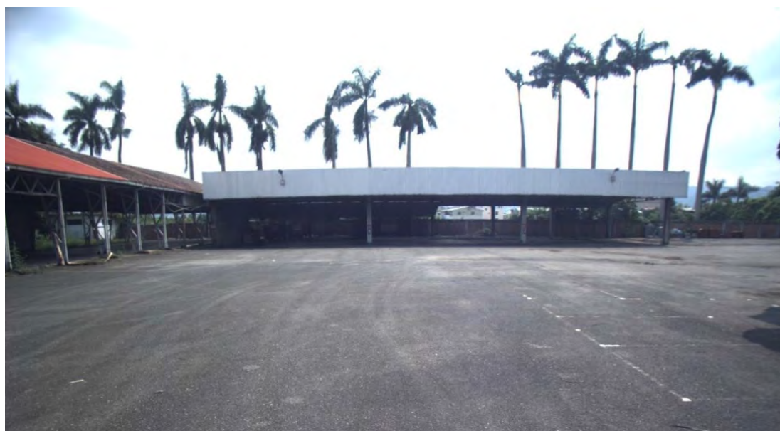
圖 3-77 中興新村高等研究園區(工管組)現場拍攝情形 3
