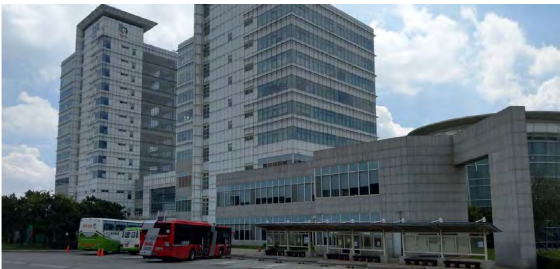
圖 3-67 中部科學園區管理局現場拍攝情形 3
