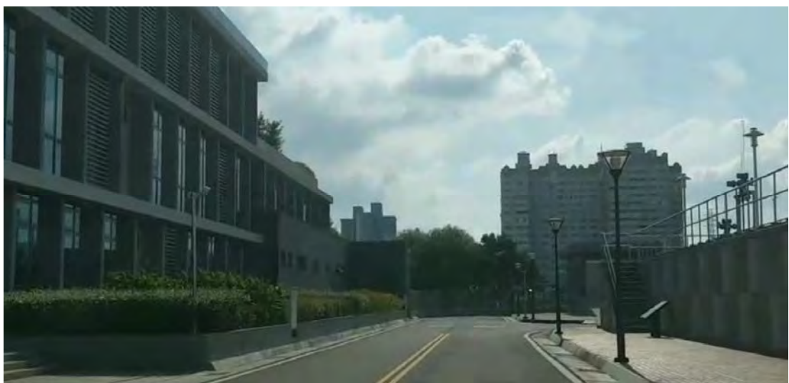
圖 3-57 文山水資源回收中心現場拍攝情形 2
