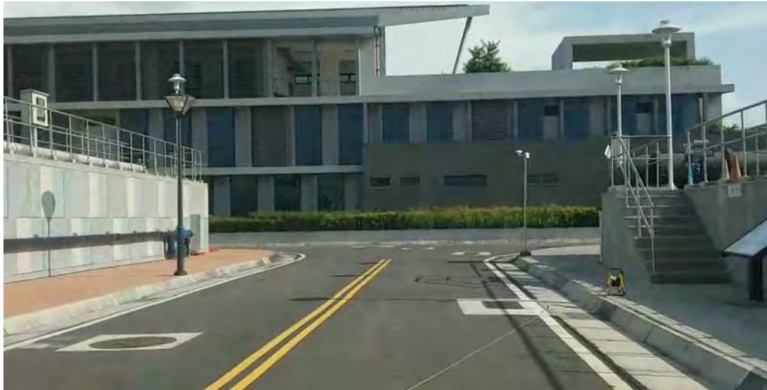
圖 3-58 文山水資源回收中心現場拍攝情形 3
