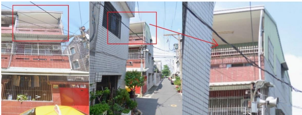
圖 5-10、拍攝角度固定影響判釋
