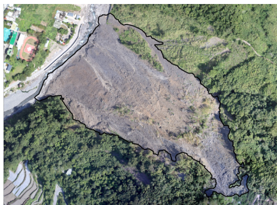
圖 3-60 第 2 次作業之崩塌範圍(人工數化)
