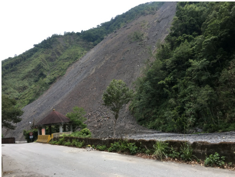
圖 3-34 秀巒地區崩塌範圍現場
