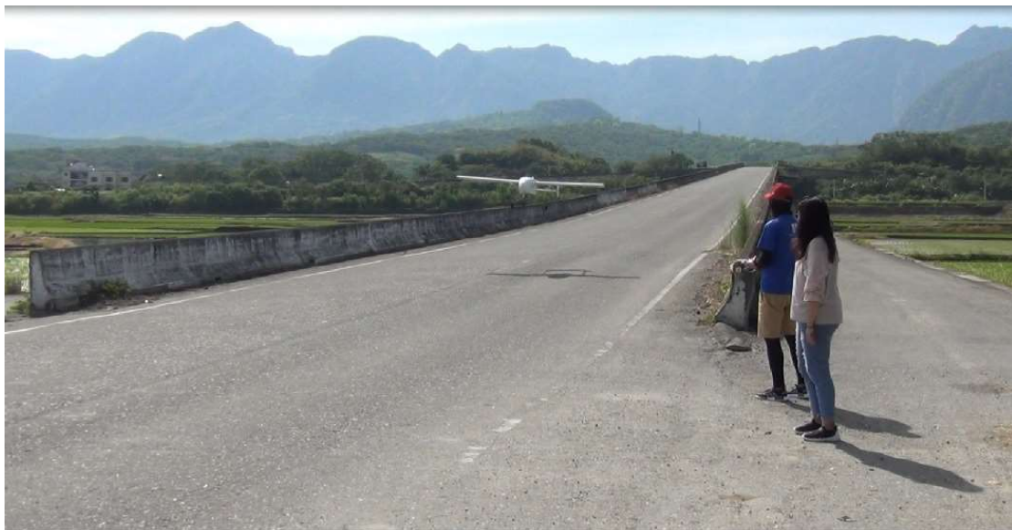
圖 3-78 花蓮縣卓溪鄉起降場地作業情形
