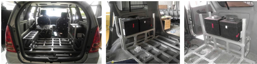
圖 3-37 車內電池安裝情形
