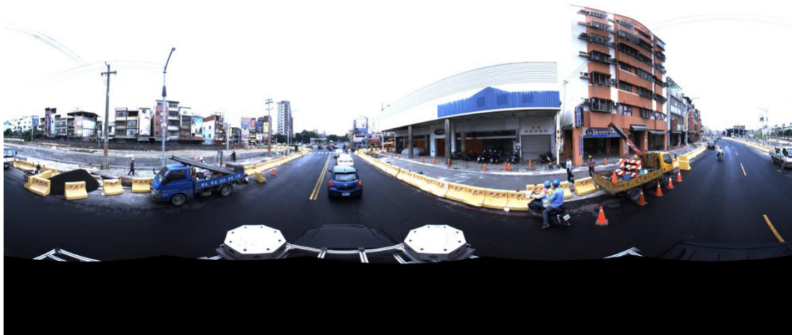
圖 2-42 車載遙測製圖技術災損地區重建影像記錄
