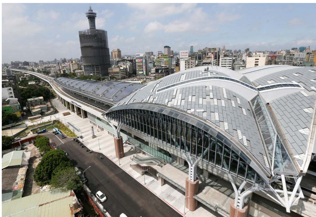
圖 5.1-2 重大交通建設指定更新作業-臺鐵新臺中車站
