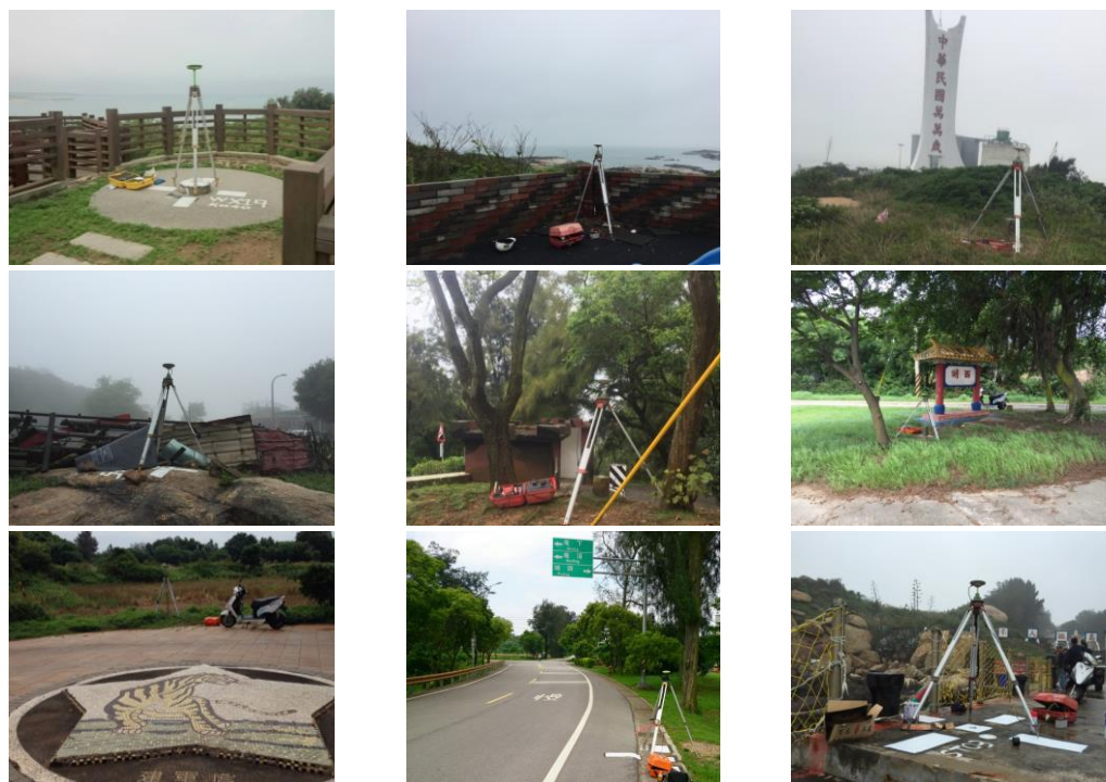
圖 4-4 GNSS 衛星定位測量作業情形
