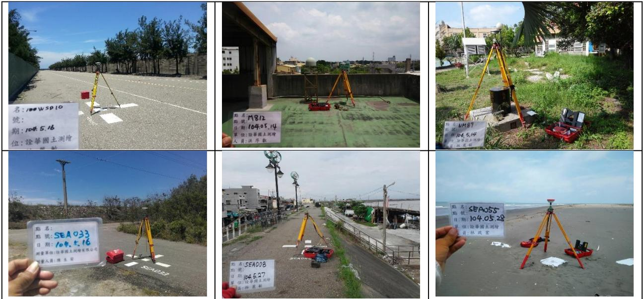
圖 3-5、GNSS衛星定位測量作業情形
