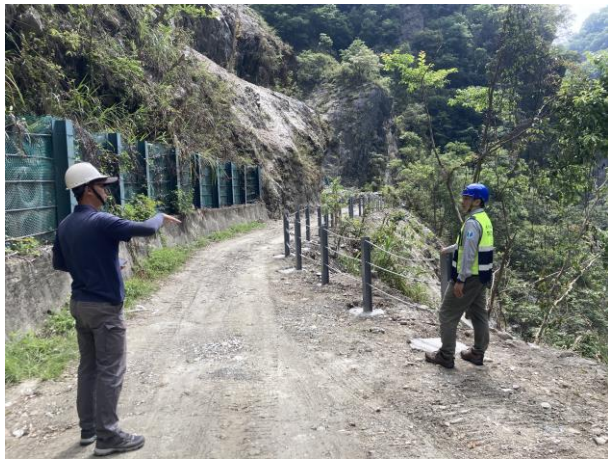
/護欄修復加固
