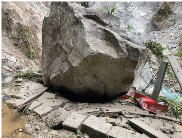
水簾洞前巨石毀損圍欄路面、取水口和邊坡滑落情況
