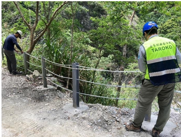
/護欄修復加固
