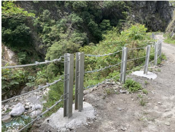
/護欄修復加固
