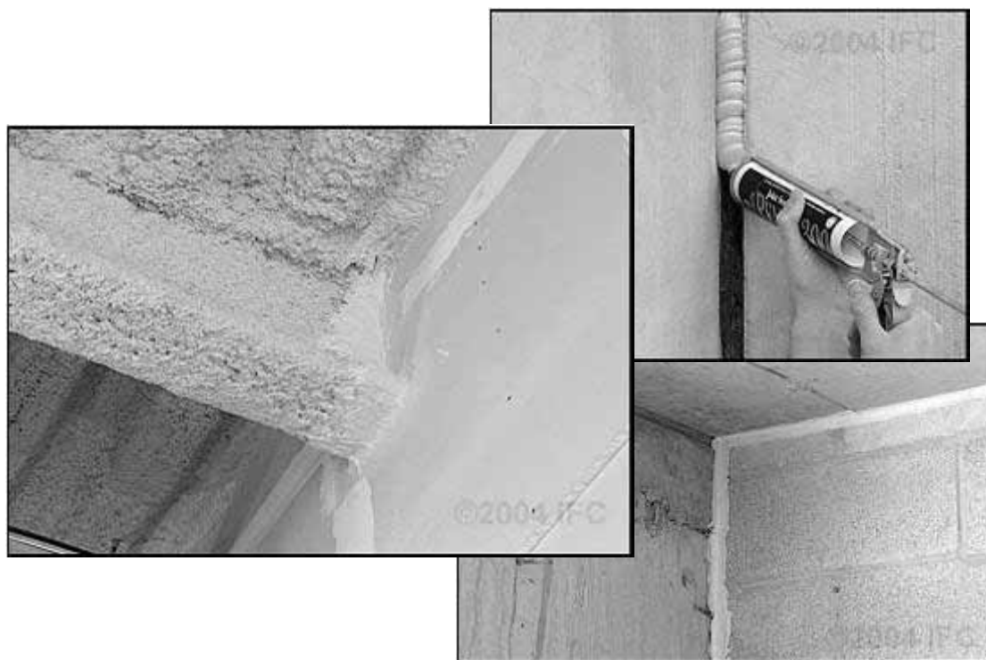
圖 6 構造間線形接合部
