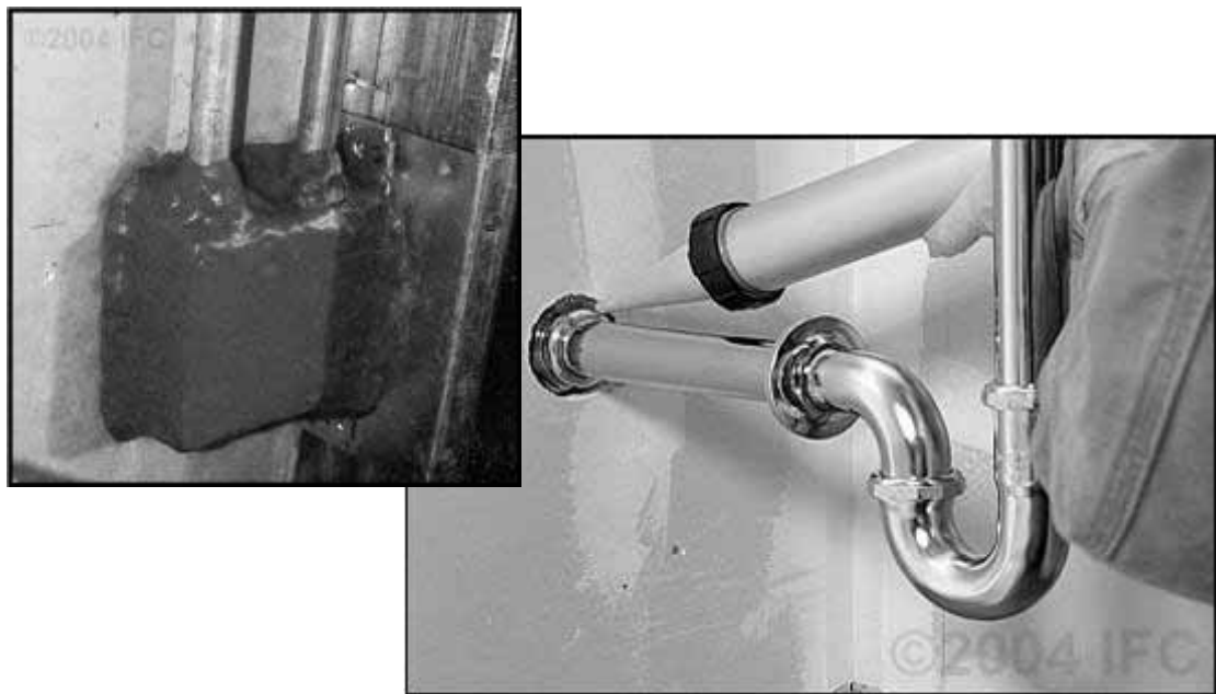
圖 8 單面穿透 (資料來源：International Building Code (IBC))
