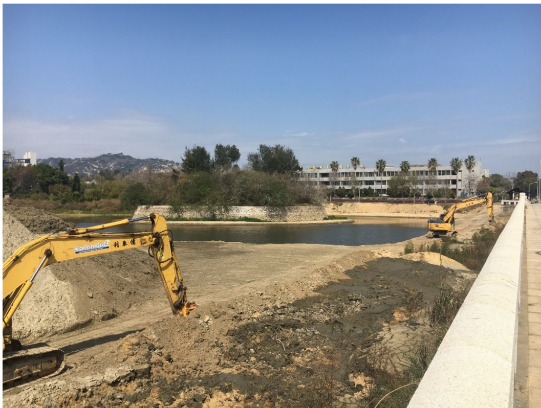
圖 4-3-23 小太湖定期清淤工程
