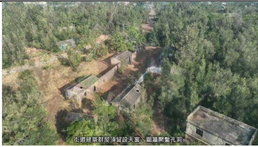
街道建築群屋頂留設天窗、開鑿開窗孔洞
