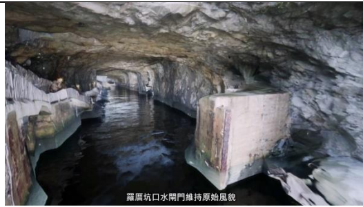
羅厝坑口水閘門維持原始風貌
