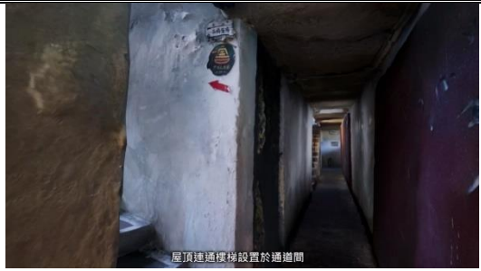
屋頂連通樓梯設置於通道間
