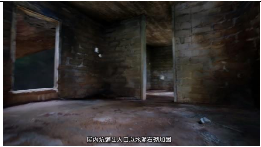
屋內坑道出入口以水泥石砌加固
