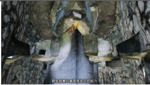
砌堡厚實的牆面提高抗炸能力
