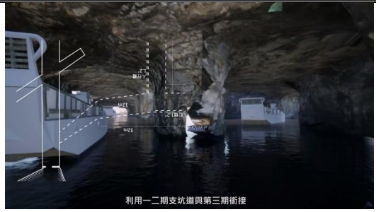
利用二期支坑道與第三期銜接
