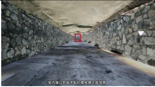
室內僅以前後茅點的樓梯通往屋頂層
