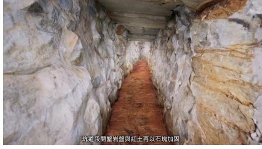
坑道段開鑿岩盤與紅土再以石塊加固
