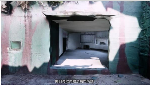
開口再以雨篷及鐵門防護
