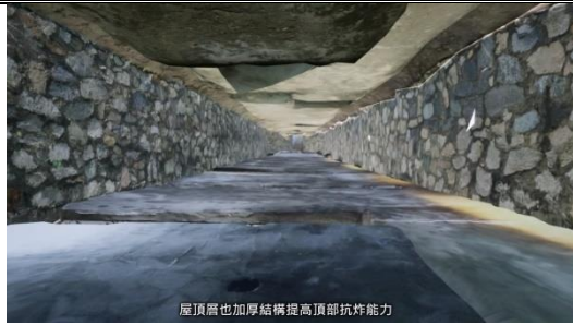
屋頂層也加厚結構提高頂部抗炸能力
