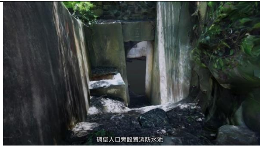
砲堡入口旁設置消防水池
