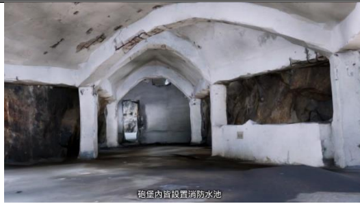
砲堡內曾設置消防水池
