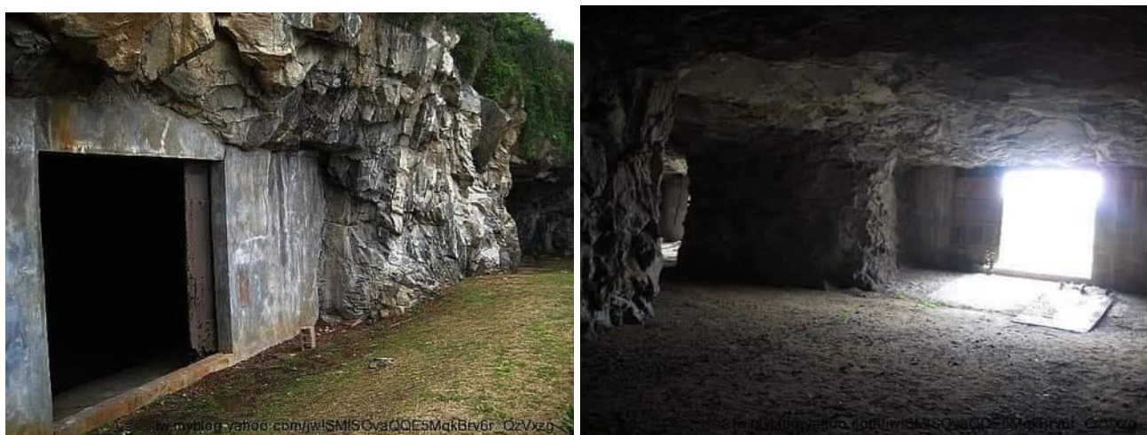
圖表 34 九宮人員坑道未修繕前狀況
