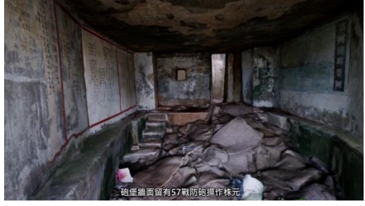
砲臺牆面留有57戰防砲操作株元
