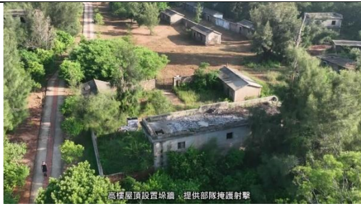
高樓屋頂設置塹壘，提供部隊掩護射擊
