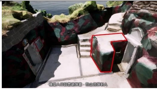
機堡入口設置避彈洞，防止流彈射入
