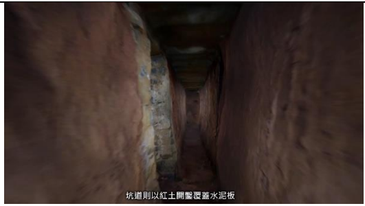
坑道則以紅土開鑿覆蓋水泥板
