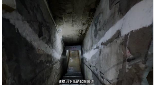
建構地下化的伏擊坑道
