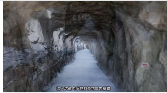
進入坑道內所見都是花崗岩壁體
