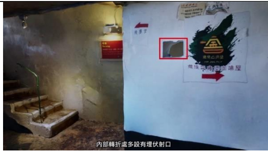
內部轉折處多設有埋伏射口
