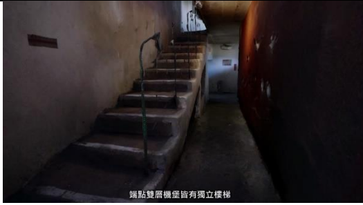
端點雙層樓堡皆有獨立樓梯
