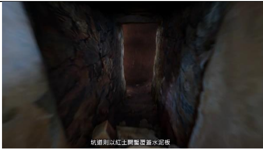
坑道則以紅土開鑿覆蓋水泥板
