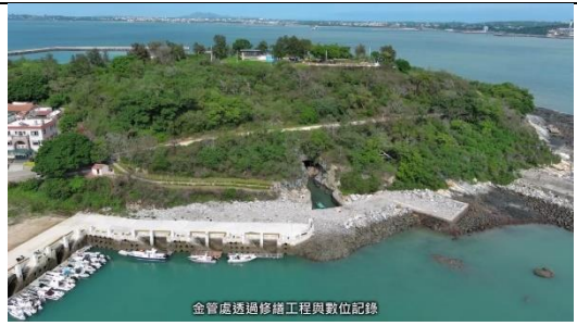
金寶處透過修繕工程與數位記錄
