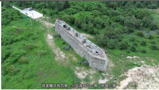
其堡體共有四層，分別為地下一層、地面三層
