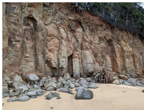
(b) 新發生之崩落
