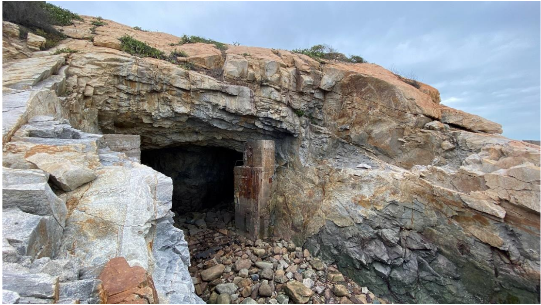
圖 5-28 大帽山坑道-小艇出口坑道
