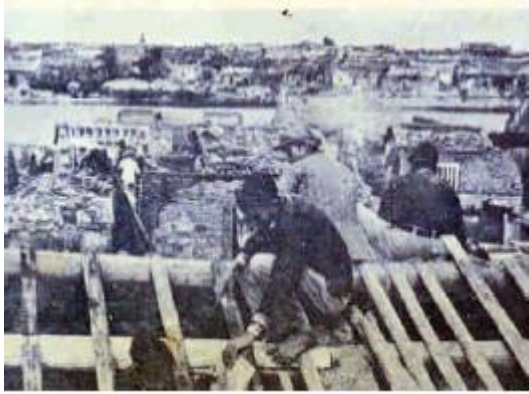
圖 4-15 居民修理炮損房屋景象
