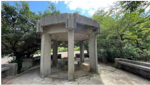
圖 5- 32 翟山連旁休憩涼亭
