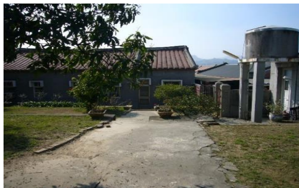
圖 2-6 江家古厝後花園圍牆拆除
