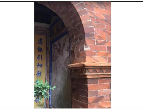
附圖 4-69 前水頭 63-1 號磚拱局部破損
