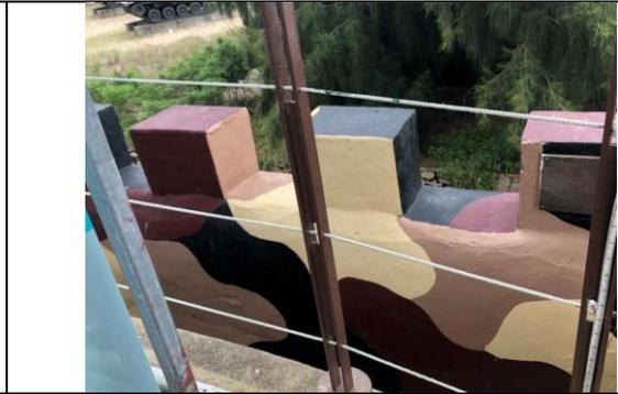
附圖 5-40 慈湖三角堡護欄間隙過大可能造成孩童的攀爬穿越
