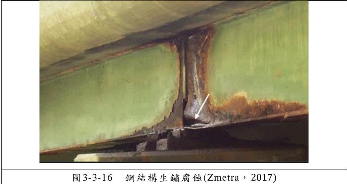
圖3-3-16 鋼結構生鏽腐蝕(Zmetra，2017)
