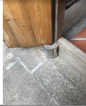
附圖 4-81 前水頭 97 號木門旋轉木基座破損
