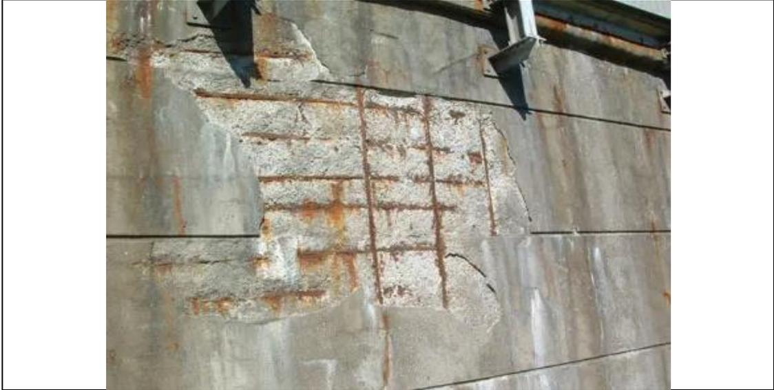
圖3-3-11 牆產生裂縫鋼筋外露(Riley, 2022)
