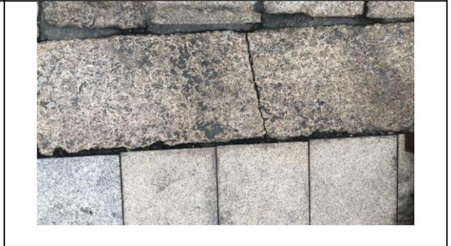
附圖 4-36 前水頭 29 號地面石材破裂
