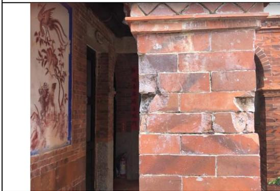
附圖 4-68 前水頭 63-1 號磚柱局部破損
