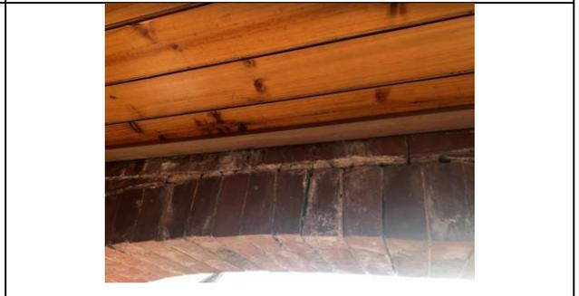
附圖 4-14 前水頭 5 號磚牆水泥砂漿局部劣化
