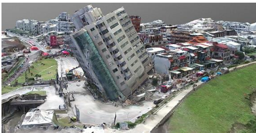
圖9、三維 Mesh 模型可呈現真實現況（花蓮雲門翠堤大樓傾斜模型）
