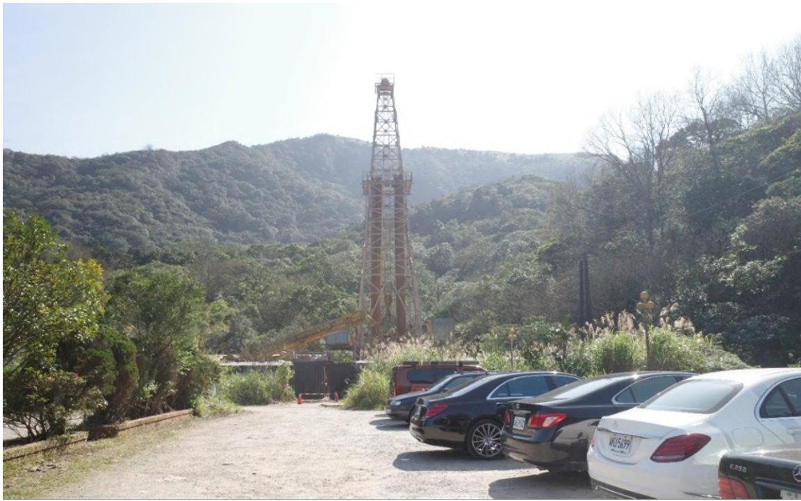
圖28 馬槽遊憩區鑽井施工現況照片
