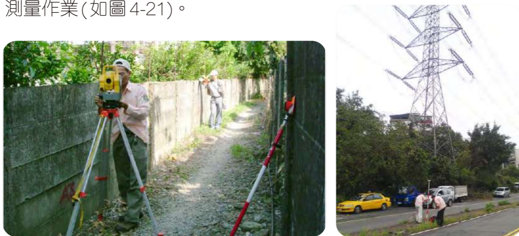
▲ 圖 4-21 台電鐵塔用地預為分割實地測量情形
