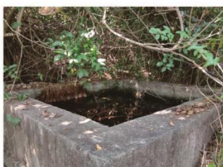
半屏山北砲臺蓄水池
