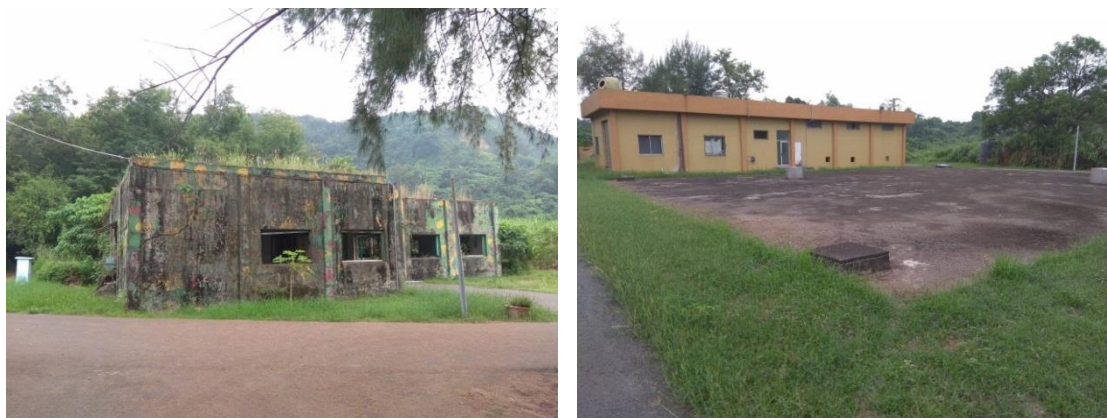
圖 55 圖 56 仁武淨水場
