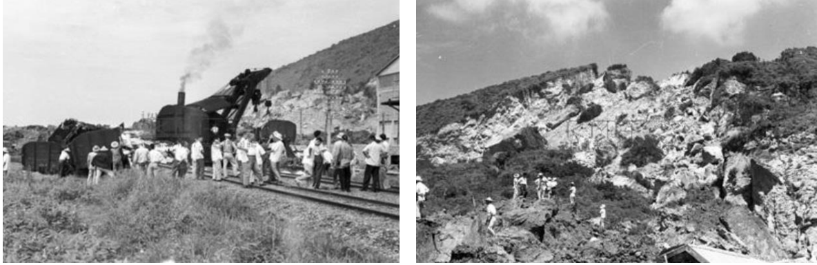
圖 6 1961 年半屏山崩塌及搶救照片
