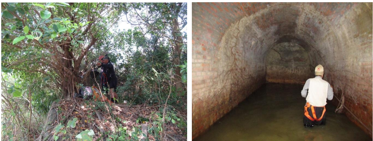
圖 24 二戰期間高雄海軍水道的潔底山配水池
