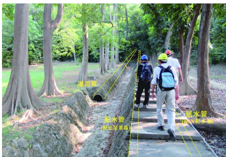
圖 57 半屏山地下水庫 配送水管位置圖
