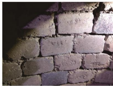
8號洞窟煙囪以耐火磚建造
