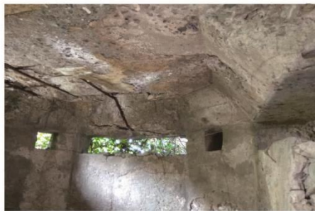
觀測所設有三個方位的觀測口
