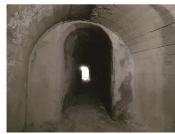
下層北砲堡內部坑道
