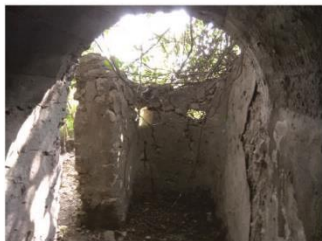
下層北砲堡東向出入口
