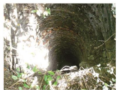
8號洞窟煙囪，高9公尺
