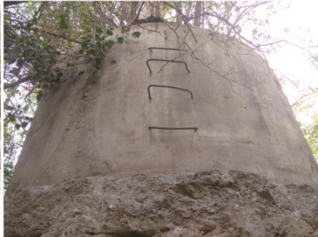
水池外部鐵梯
