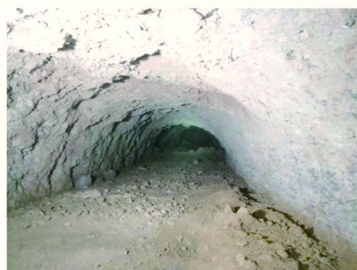
北支坑(625洞窟有兩條支坑)
