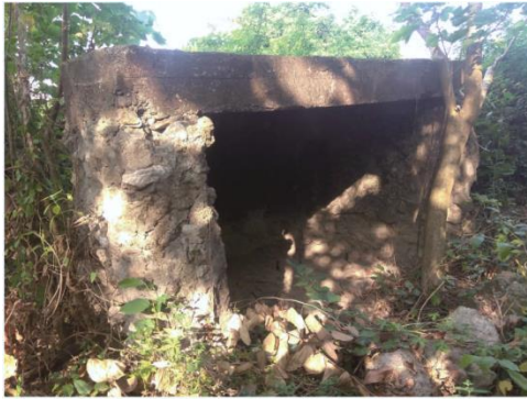
機槍堡頂部為RC底部為咾咕石結構
