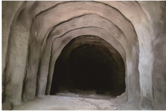
9號洞窟施工單位以水泥噴漿保護
