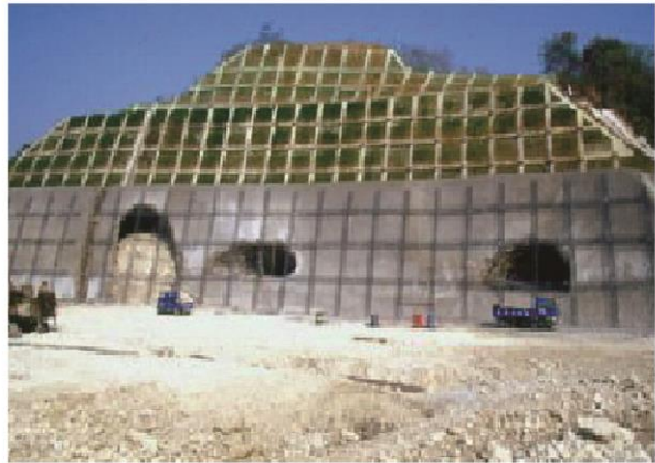
2004年高鐵聯外道路施工時挖到酸素工場
