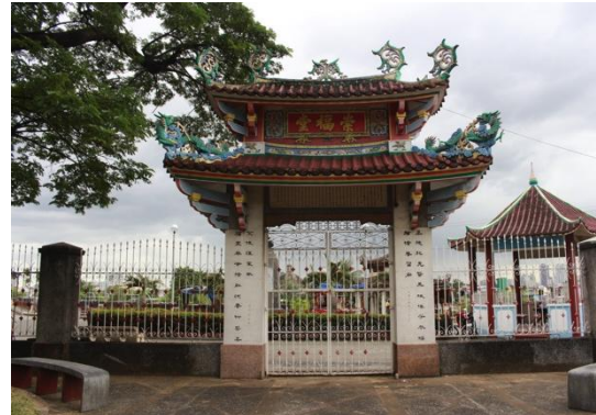
圖 3-34：崇福堂外牆牌坊
