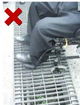
室外通路設置水溝格柵開口不得大於1.3公分，且開口應與主要行進方向垂直，以免造成輪椅前輪陷入。
