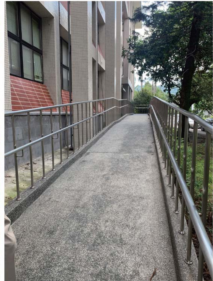
206.4 坡道防護設施
