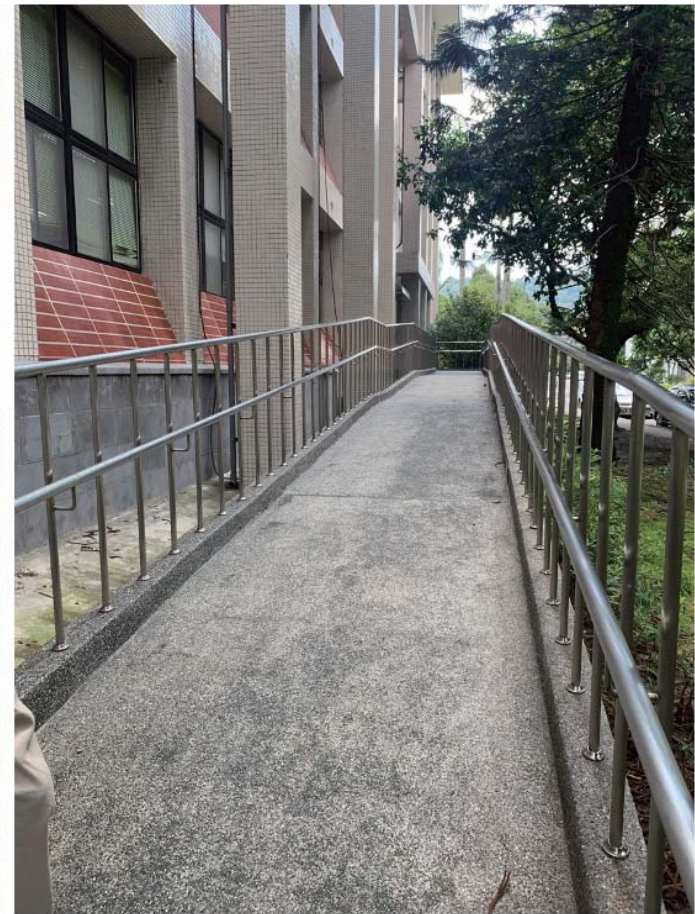
206.4 坡道防護設施
