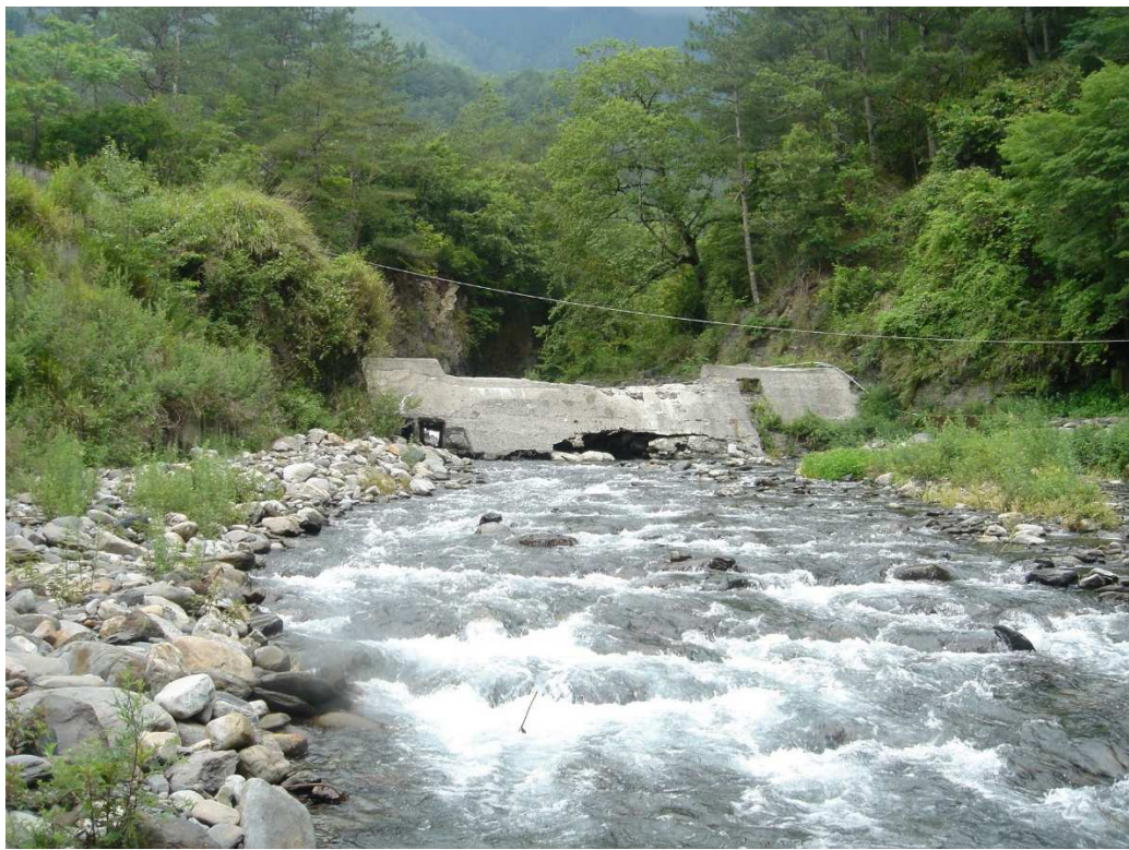
圖 27 2004 年七家灣溪二號壩崩壞的情形，圖左可見復育中心取水口的位置
