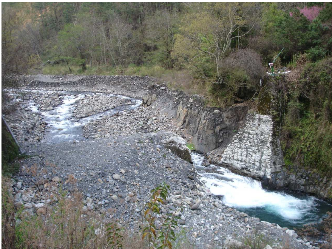
圖 6 2011 年五月底，雪霸國家公園管理處順利完成七家灣溪一號防砂壩拆除改善工程，開通溪流生物生態棲地廊道
