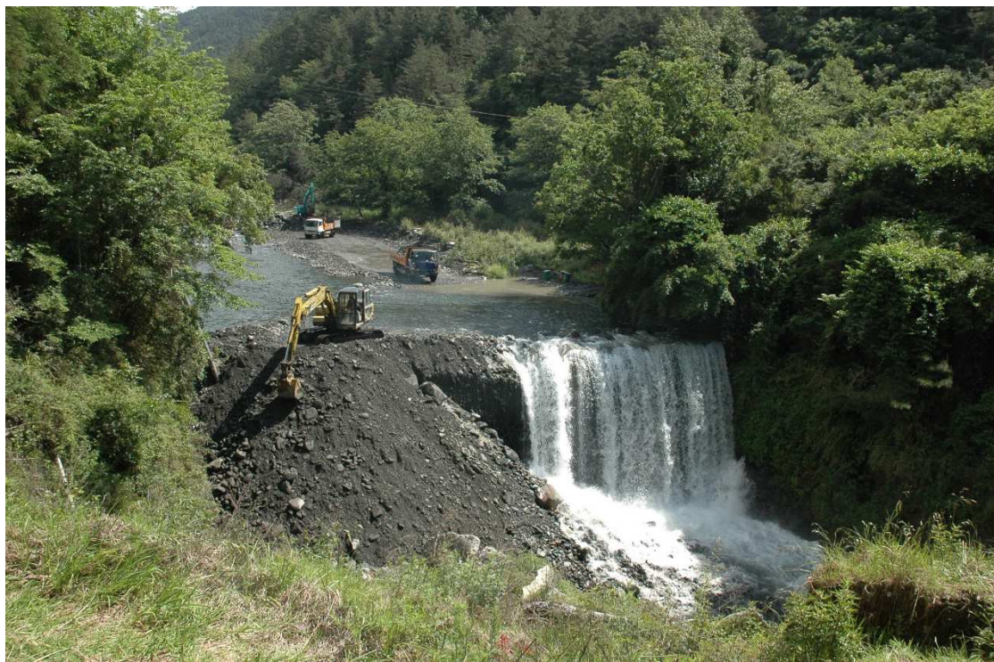
圖 2 退壩還水於河 - 七家灣溪一號壩改善工程
