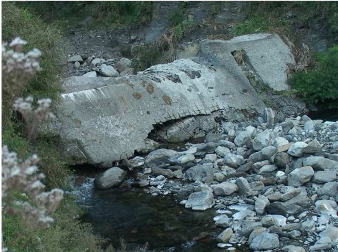
圖 26 2002 年七家灣溪二號壩崩壞的情形，右側是魚道的殘跡
