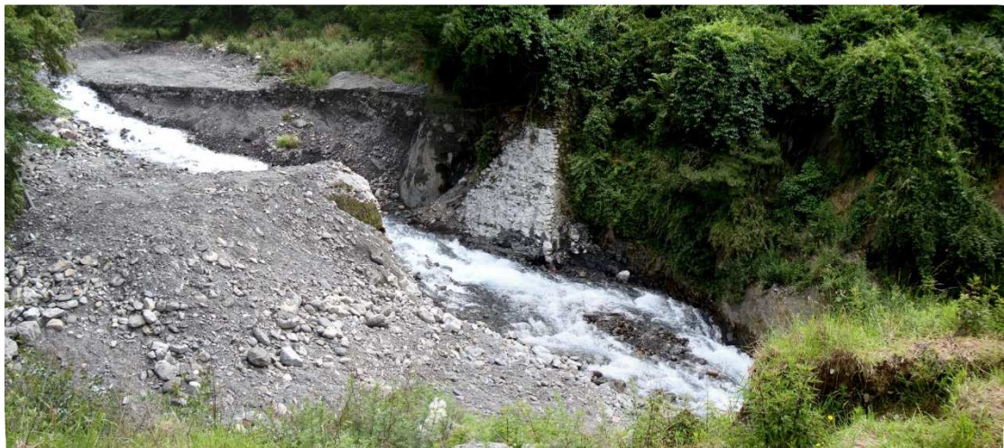
圖 29 七家灣溪一號壩拆壩之後的情形
