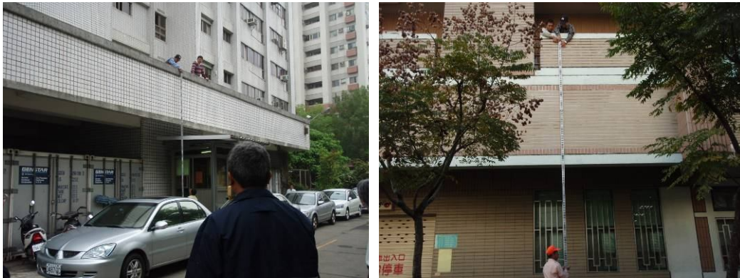
圖 1 普通水準測量作業情形
