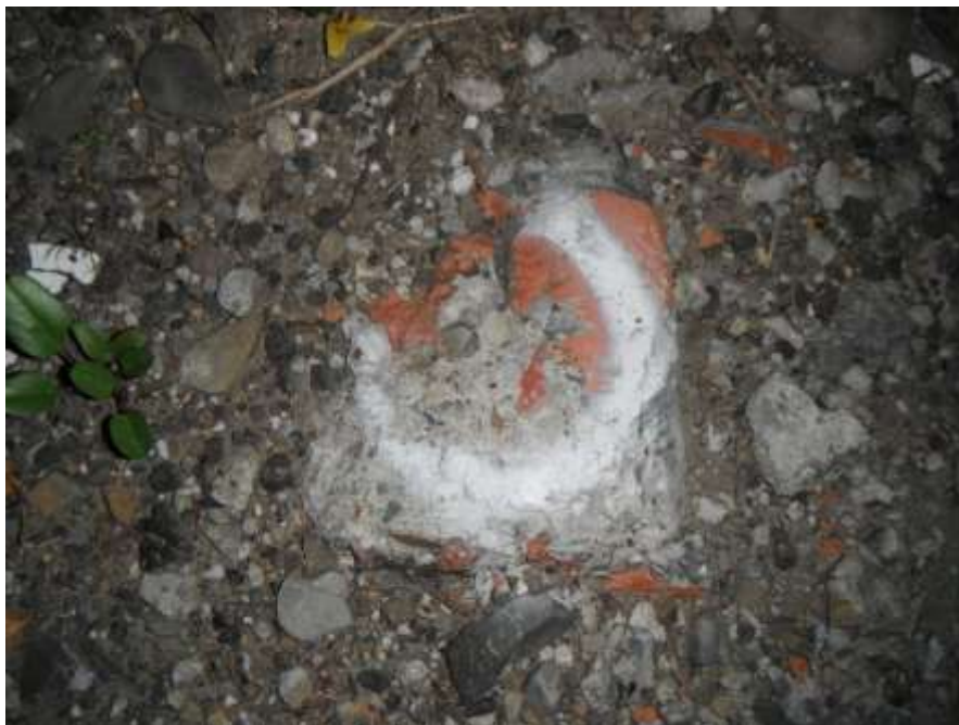
圖 5-7 臺灣水準原點高程基準網 BM4 水準點現況照片（標石嚴重剝損）
