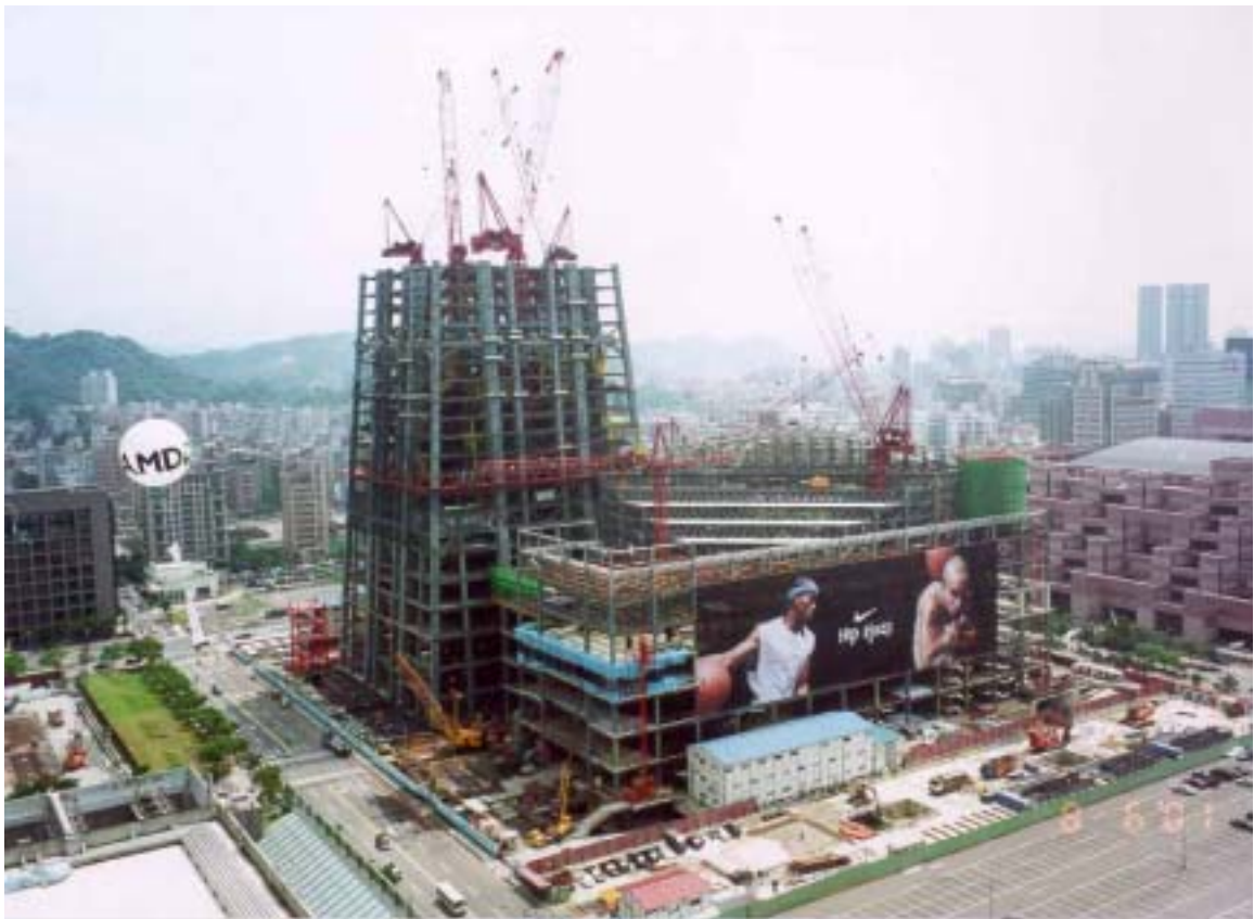
相片 4. 進行 22 層鋼構吊裝之工地全景(2001/8)
