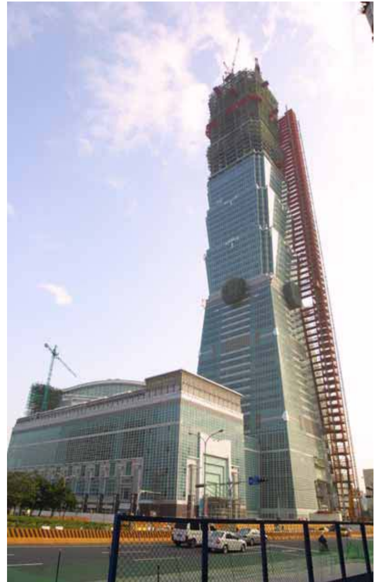
相片 6. 進行 70 層鋼構吊裝之工地全景(2003/1)
