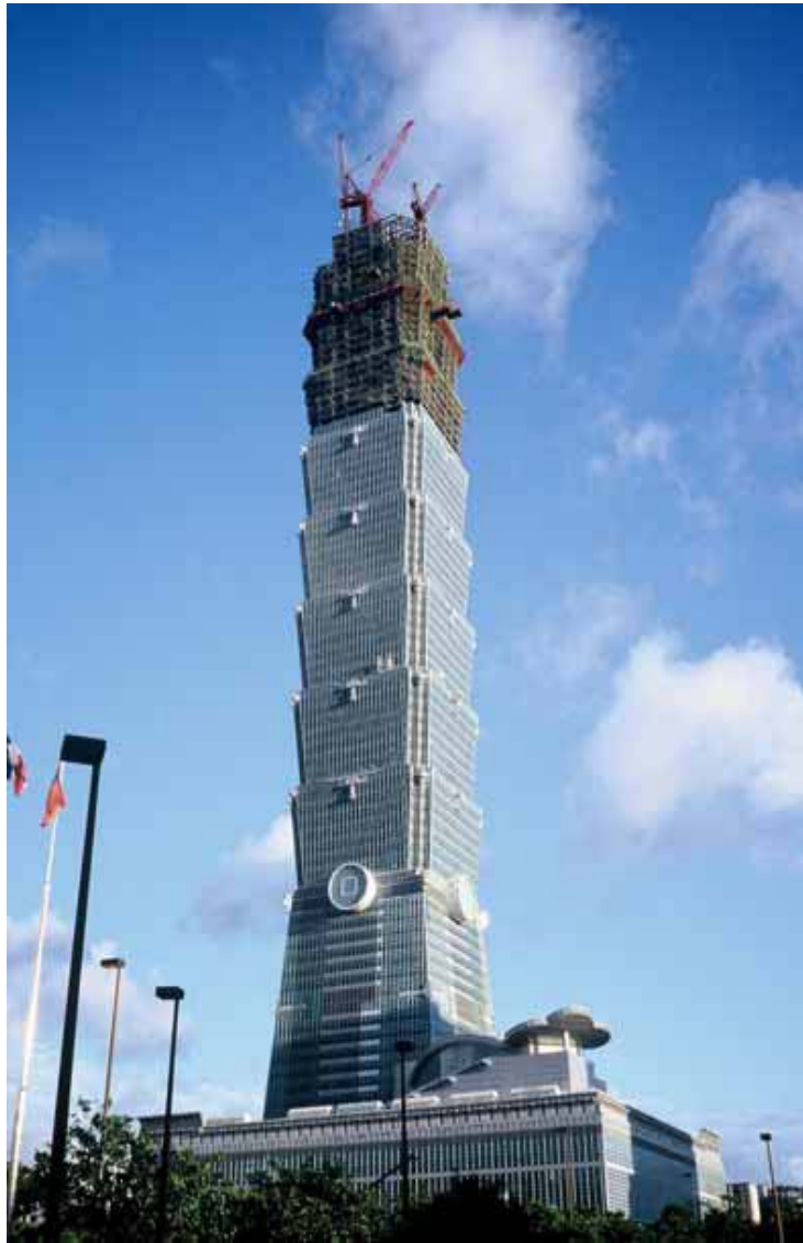
相片 7. 進行 90 層鋼骨吊裝之工地全景(2003/4)
