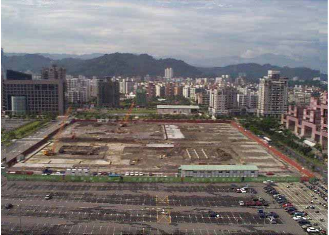
相片 3. 連續壁導溝、沉澱池施工中之工地全景(1998/6)
