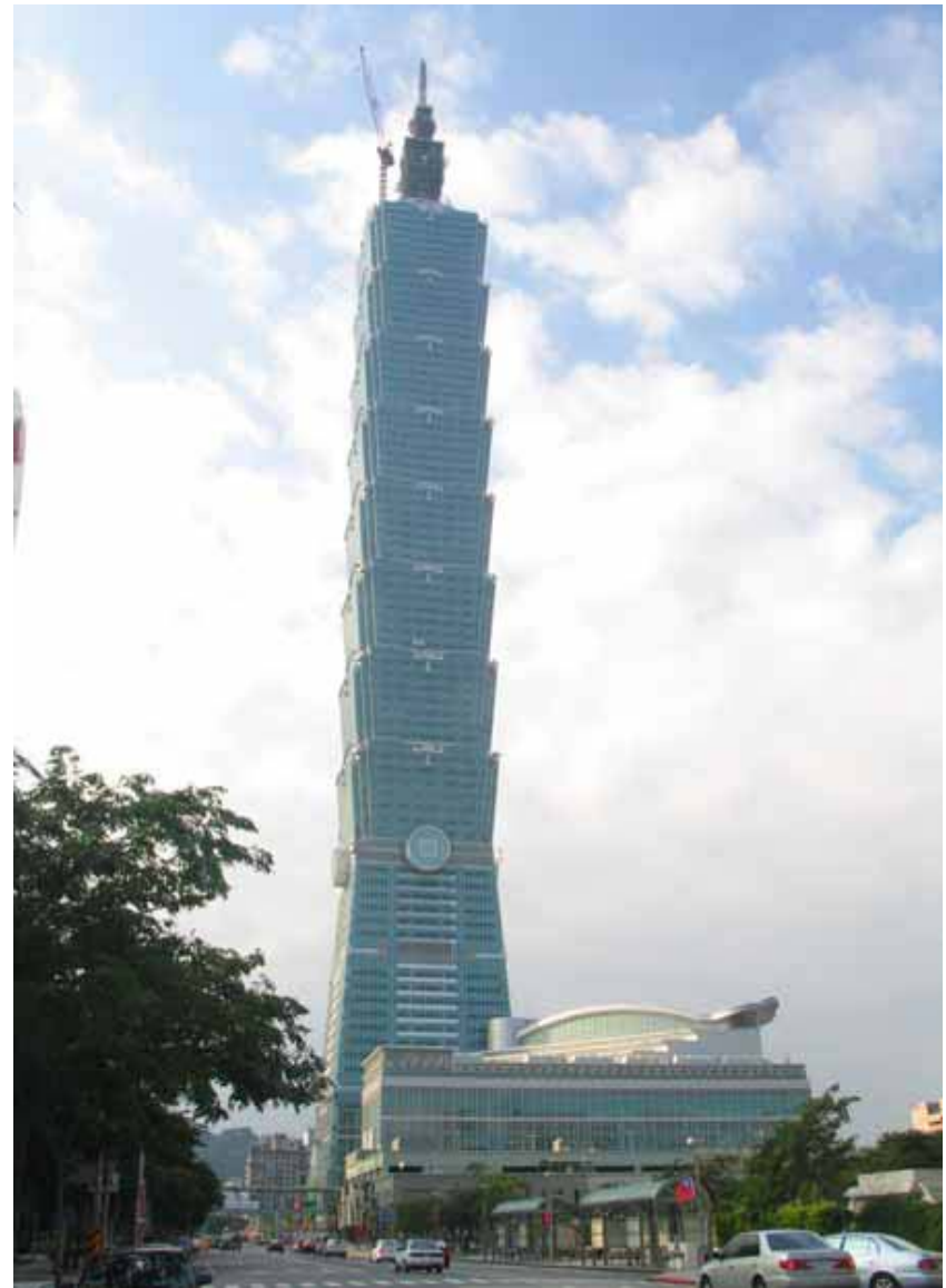
相片 8. 尖塔結構完成(508m)之大樓全景(2003/10)
