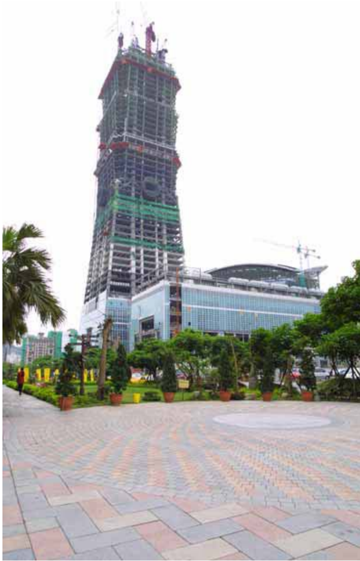
相片 5. 進行 53 層鋼構吊裝之工地全景(2002/3)
