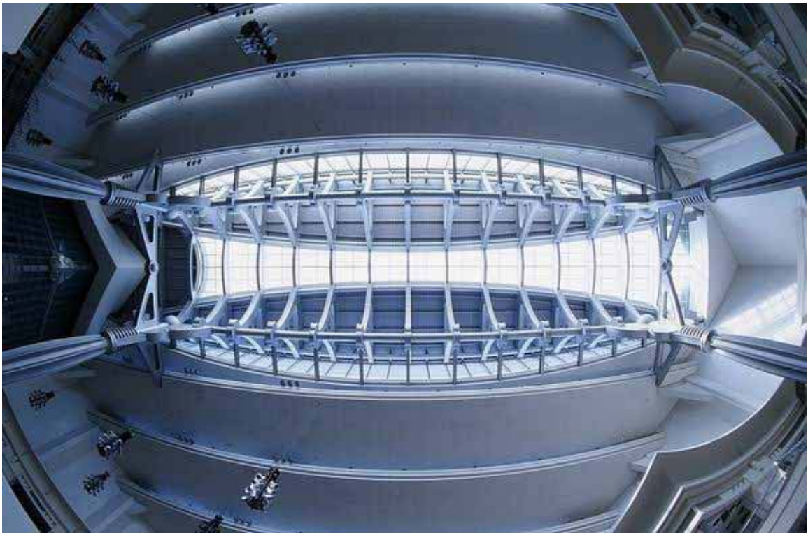
相片 9. 裙樓屋頂採光罩結構
