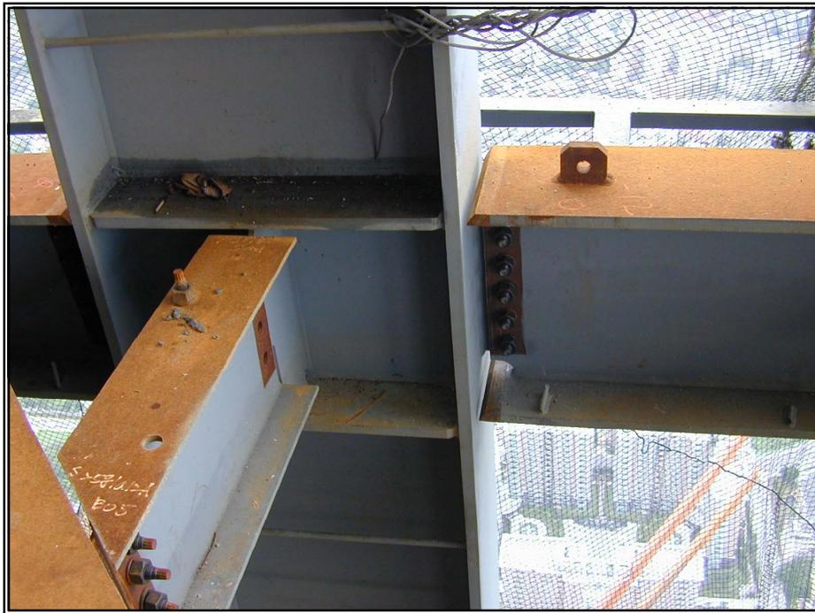
(7). 鋼樑與 H 型鋼柱(強軸)接頭
