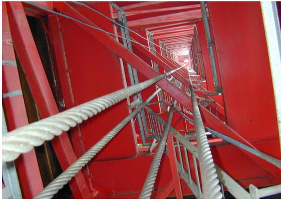
圖 10.5 塔節內增設鋼索防墜落
