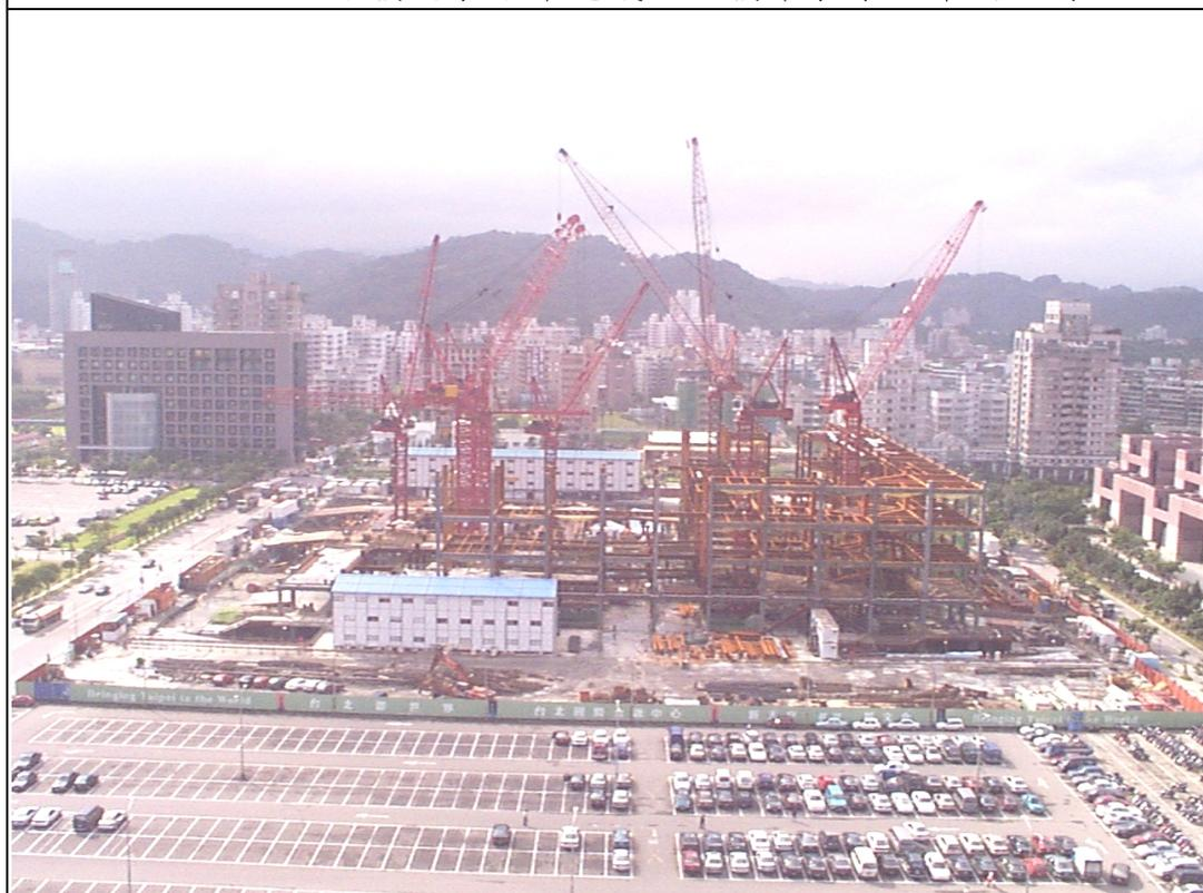
2000.11.10-塔樓吊裝第一節鋼構、裙樓吊裝第三節鋼結構
