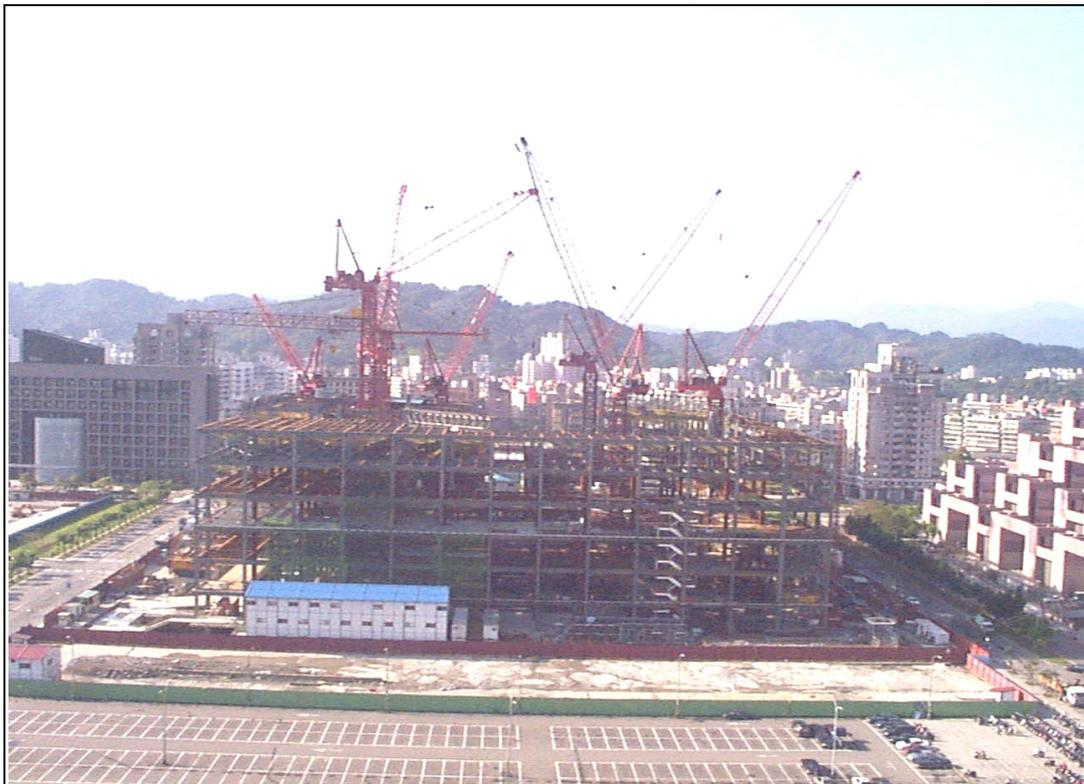
2001.05.12-塔樓安裝第三節、裙樓吊裝屋頂桁架
