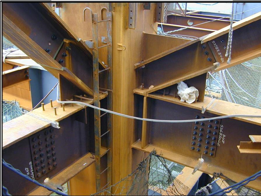
(5). 鋼樑與箱型鋼柱接頭
