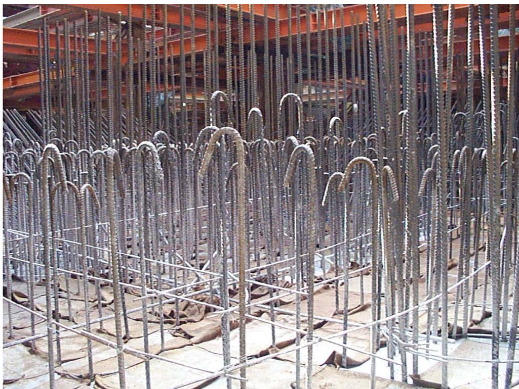
圖 6.21 塔樓基礎版鋼筋組立
