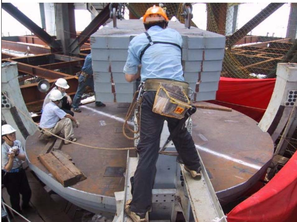
圖 9.8 質量塊吊裝完成
