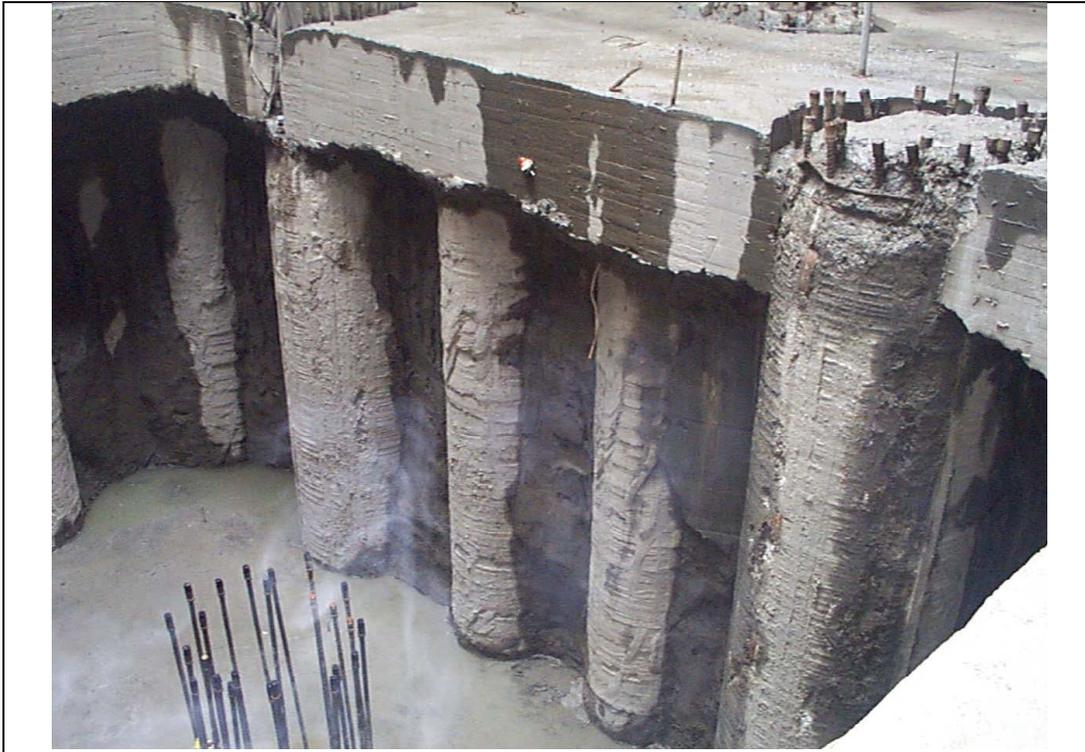
塔樓電梯機坑開挖深度 GL-27.8 M
