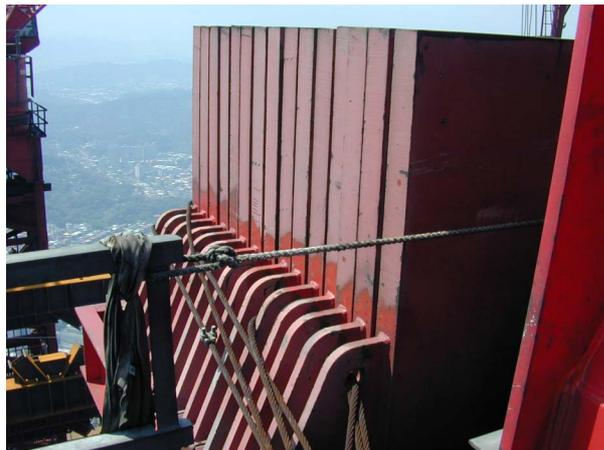
圖 10.3 使用鋼索將配重塊固定
