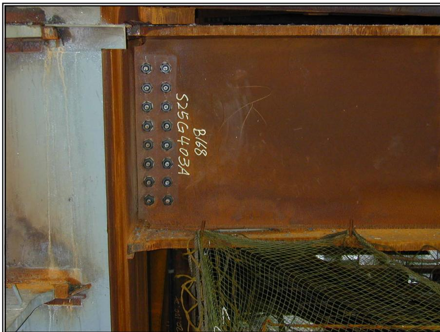
(6). 鋼樑與 H 型鋼柱(弱軸)接頭
