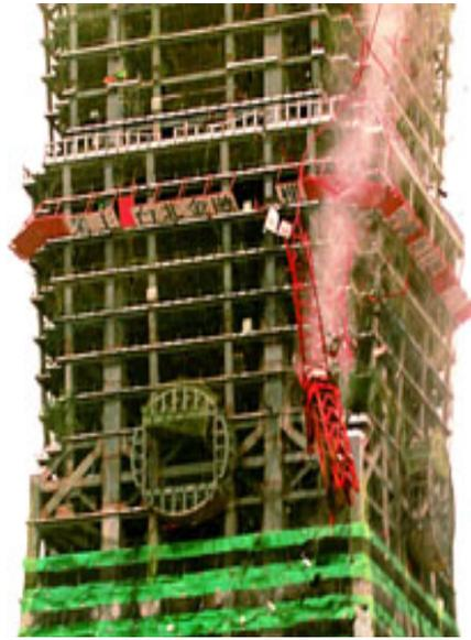
圖 10.1 T/C#2 倒塌墜落
