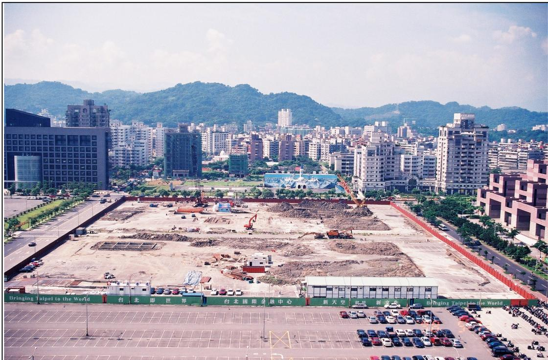
1998.05.13-連續壁工程沉殿池與鋪面整地施工
