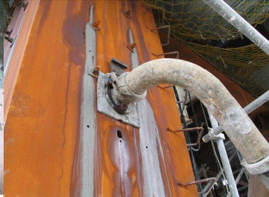
圖 6.13 柱內灌漿入口設備
