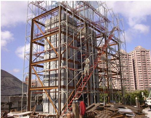
圖 6.10 柱內鋼筋籠
