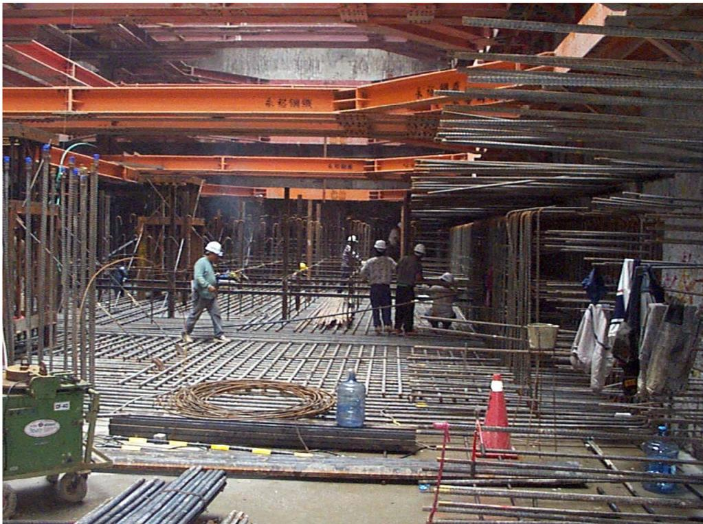
圖 6.20 塔樓基礎版剪力筋
