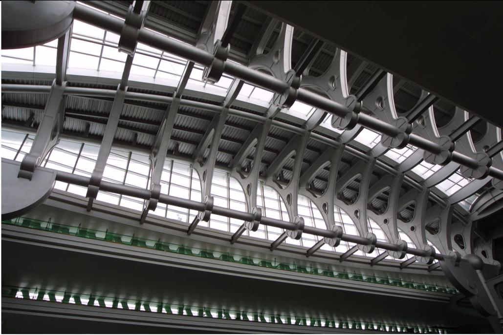
圖 7.28 採光罩屋頂桁架
