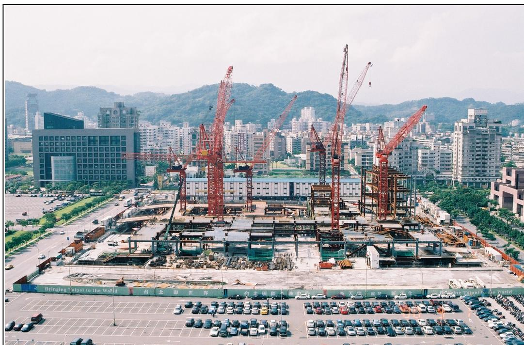
2000.09.01-塔樓安裝塔吊完成、裙樓吊裝第二節鋼結構
