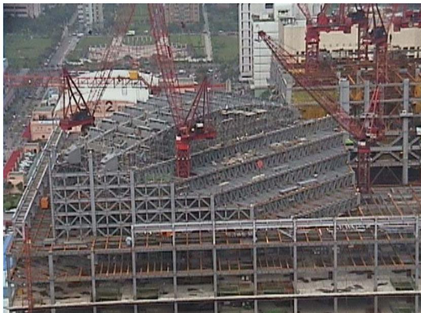
圖 7.27 採光罩結構完成
