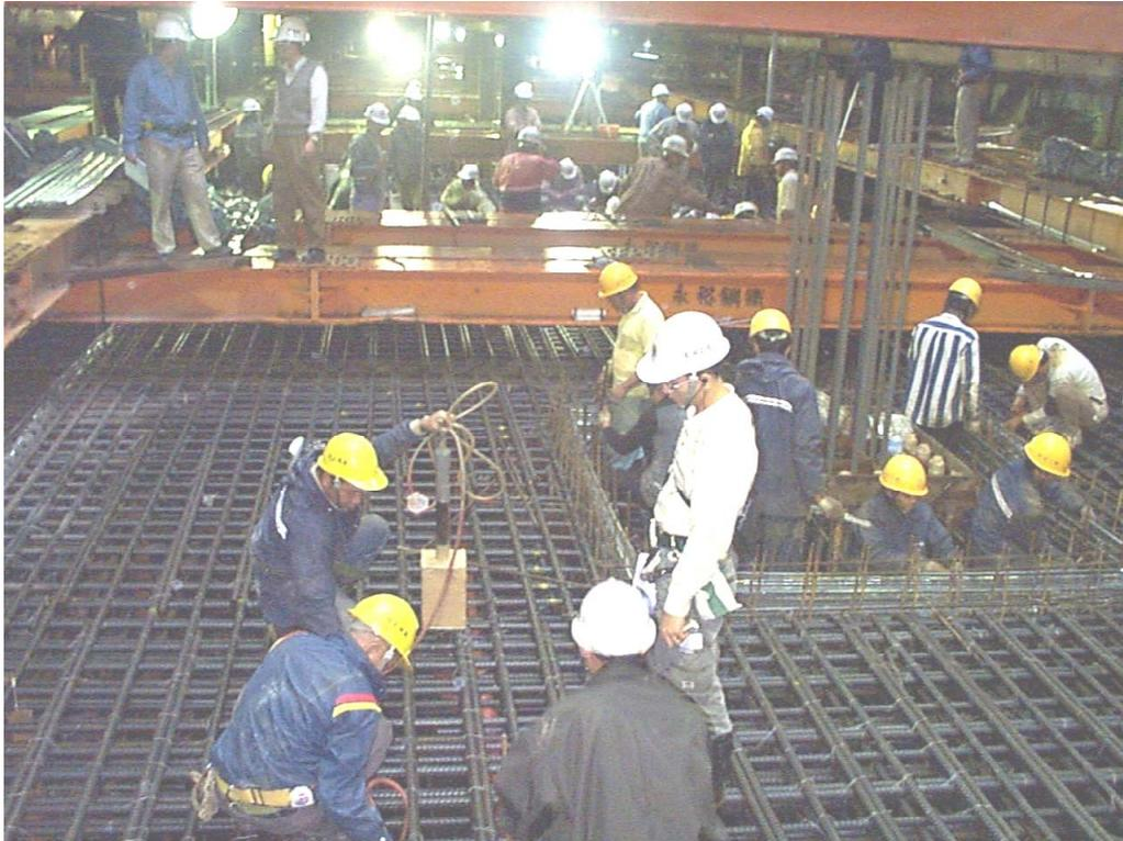
圖 6.23 裙樓 1F 版鋼筋綁紮與澆置混凝土
