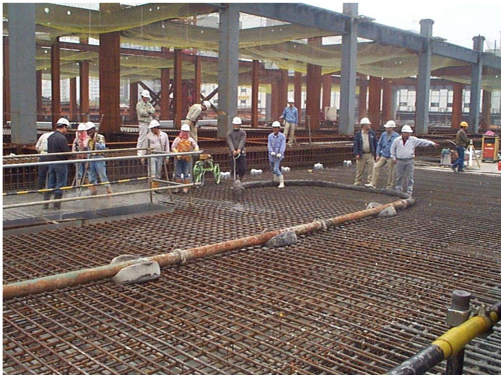
圖 6.24 塔樓高層區樓版配筋與現場管口坍流度測試
