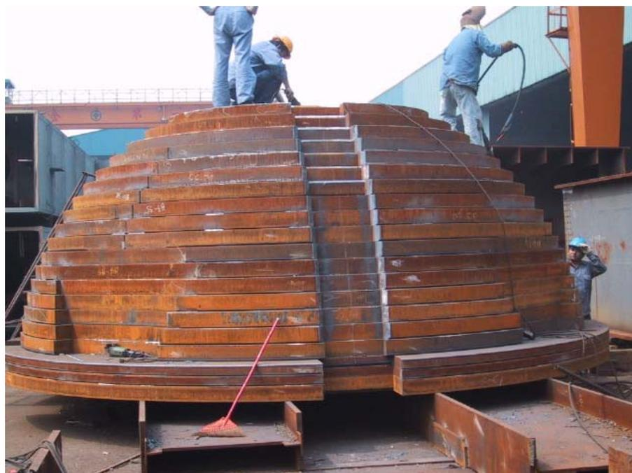
圖 9.4 質量塊底座支架(Cradle)吊裝完成
