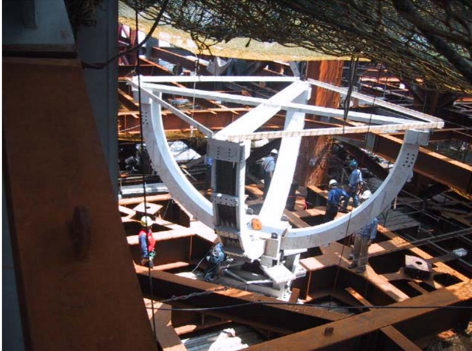
圖 9.5 質量塊吊裝與電銲
