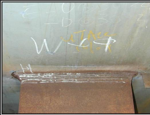
圖 7.24 銲後並切除翼板兩端多餘銲道及以研磨處理
