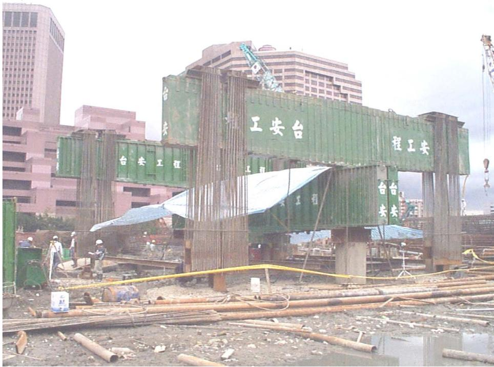
圖 4.3 基樁靜動載重試驗
