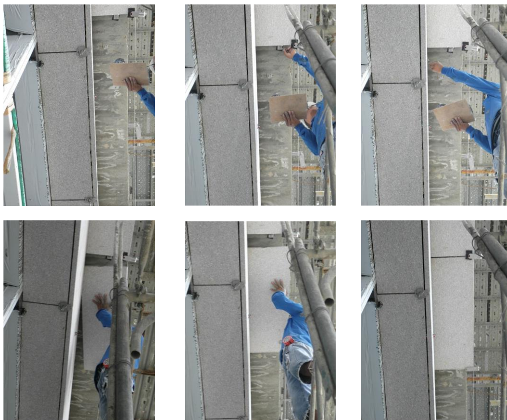
圖 3-22 B5 案倒吊版施工照片
