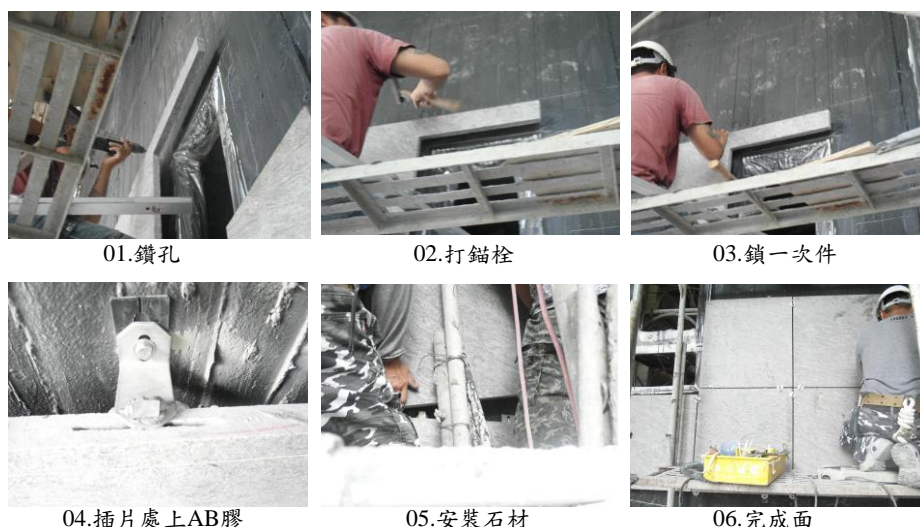
圖 3-17 B4 案牆面安裝步驟照片
