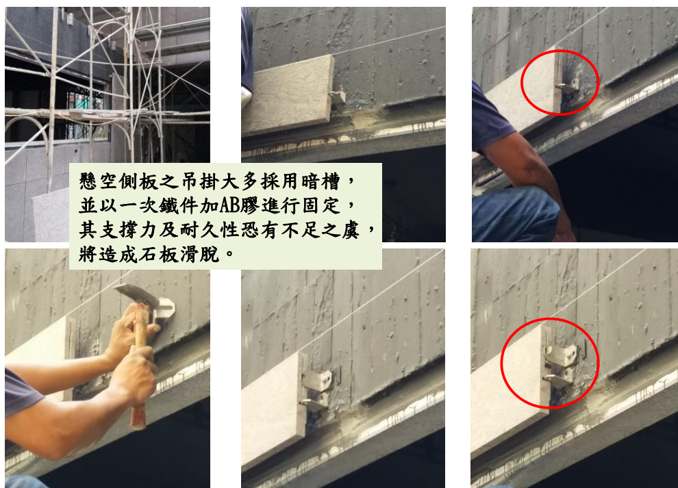
圖 3-18 B4 案懸空側板安裝步驟照片 (資料來源：本研究拍攝整理)
