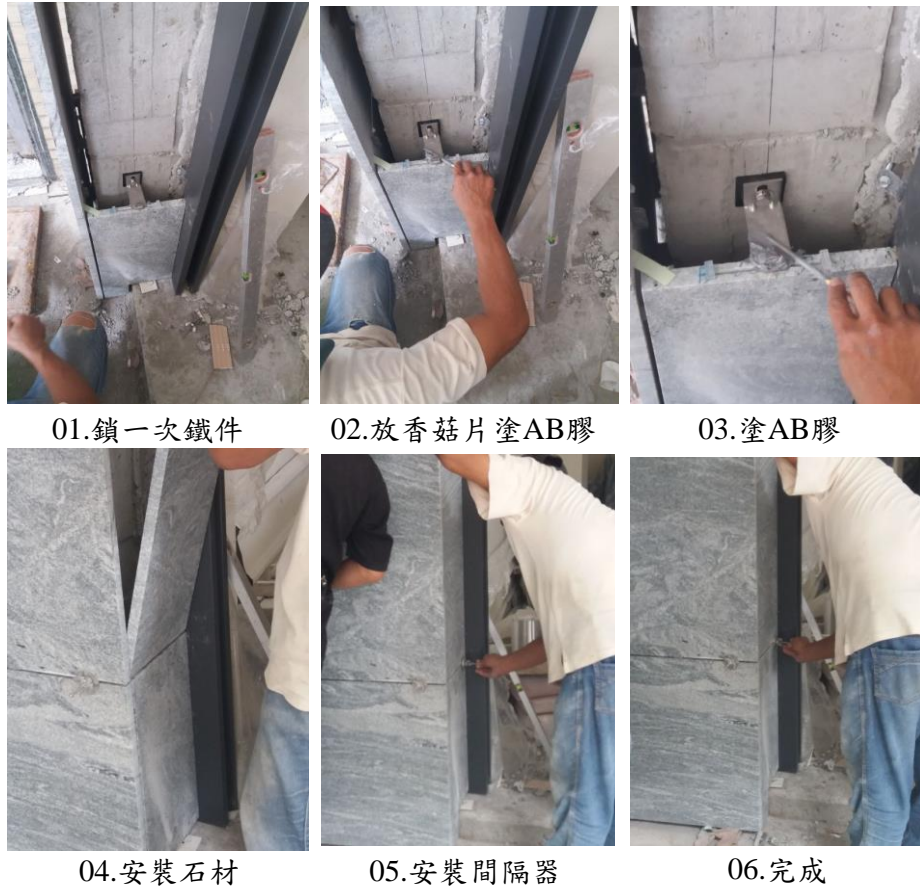
圖 3-12 B2 案牆面安裝步驟照片
