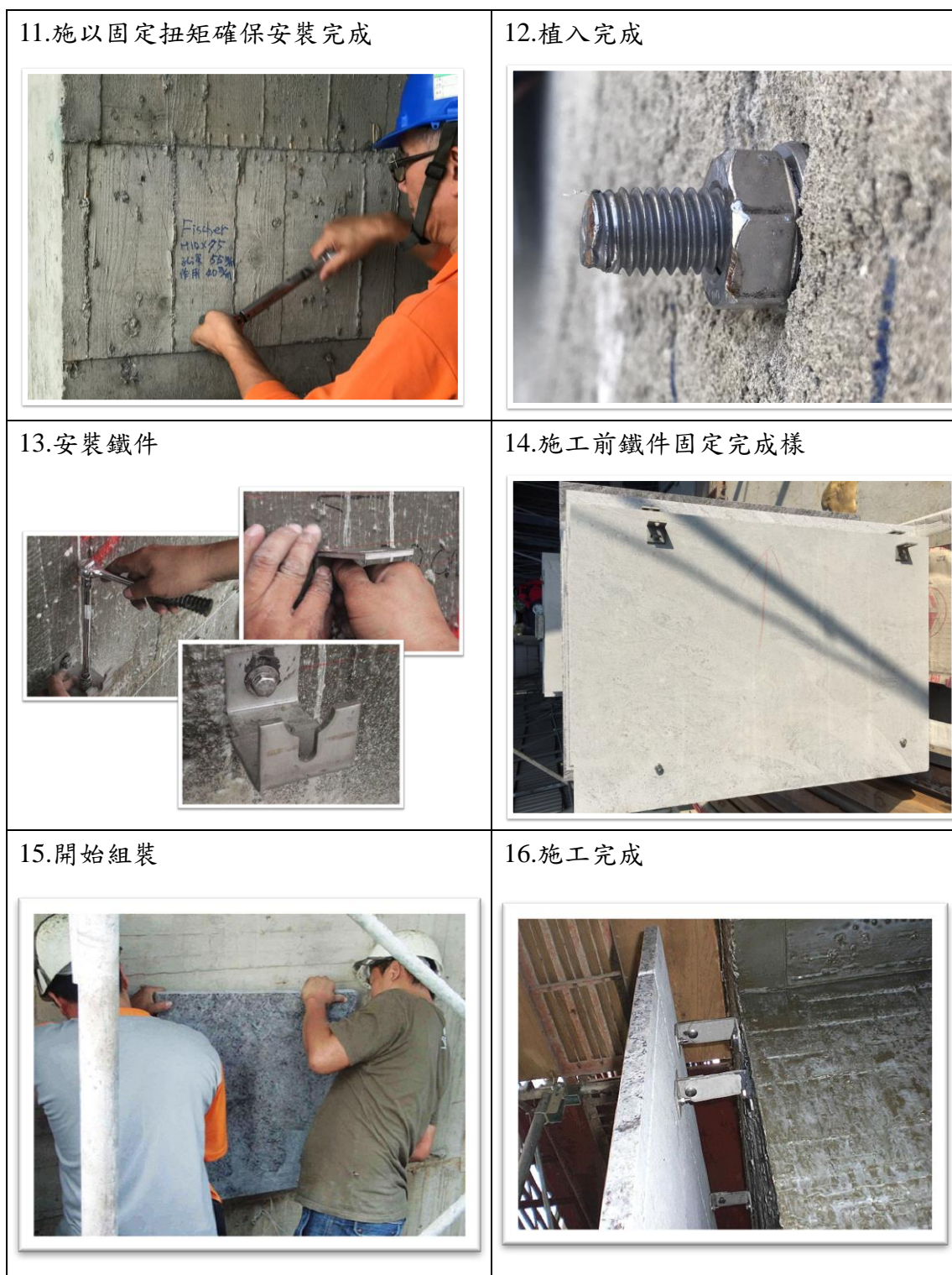
圖 2-16 背栓擴孔固定工法施作流程
