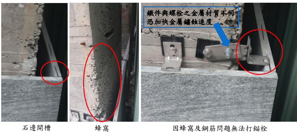
圖 3-15 迴避蜂窩處及鋼筋位置施作照片
