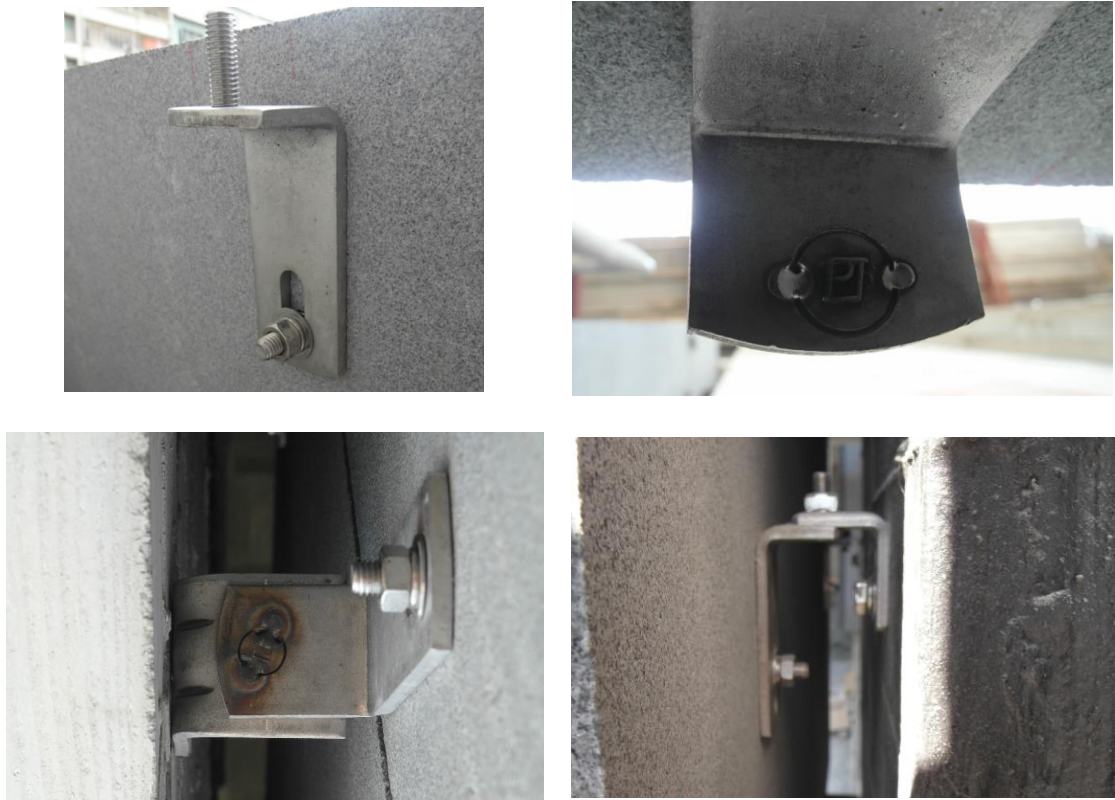
圖 3-9 二次鐵件上銲接螺絲照片
