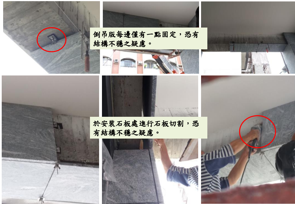
圖 3-13 樑下倒吊版施作照片
