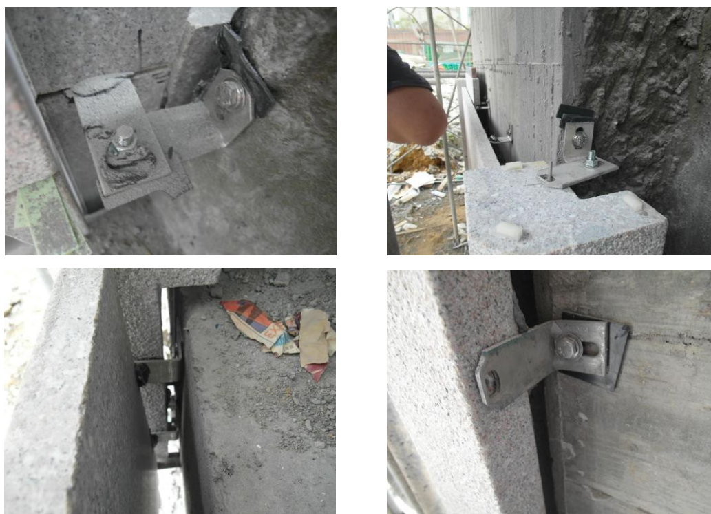
圖 3-21 B5 案角隅處施工照片 (資料來源：本研究拍攝整理)
