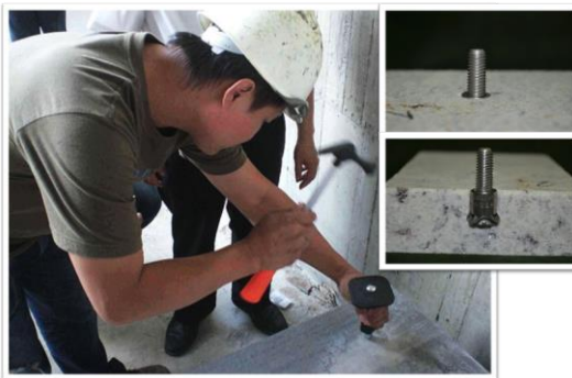
7.混凝土側膨脹錨栓安裝(確認深度)
