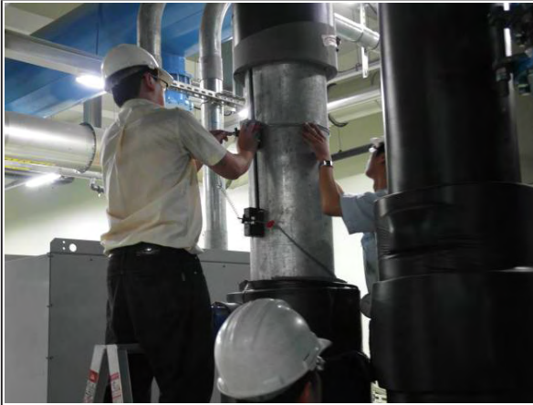
【空調主機冰水管路超音波流量計安裝】
