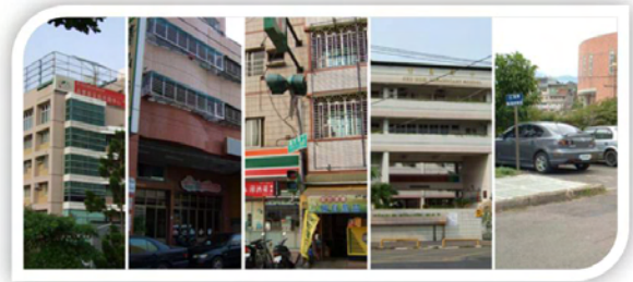
圖1.3 既有建築物，外殼、綠化、保水性能均不足
