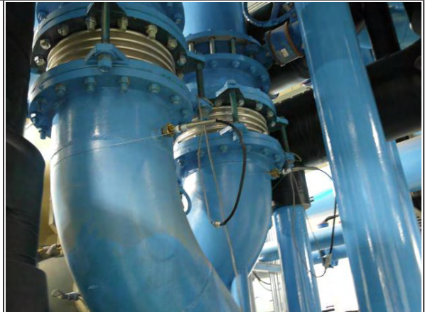
【空調主機冷卻水出入端溫度計安裝】
