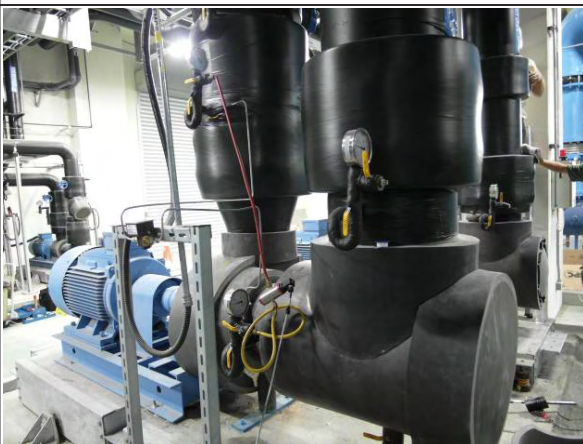
【冰水泵壓差計安裝】
