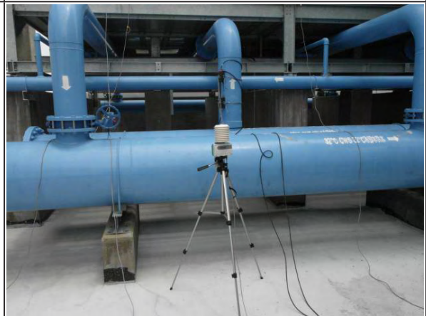
【冷卻水塔外氣溫濕度計安裝】
