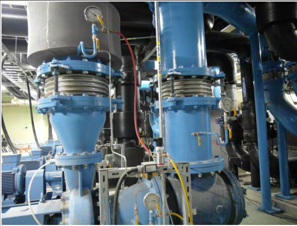
【冷卻水泵壓差計安裝】
