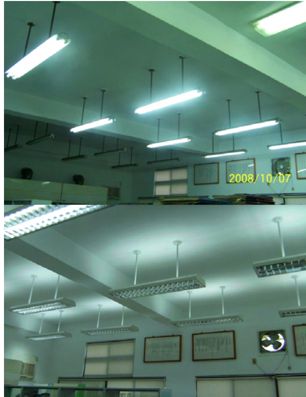
圖3.12以高光源及燈具效率且防眩光之設計代替原效率不佳的照明
