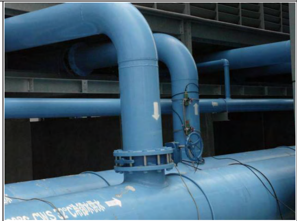
【冷卻水塔超音波流量計管路2安裝】
