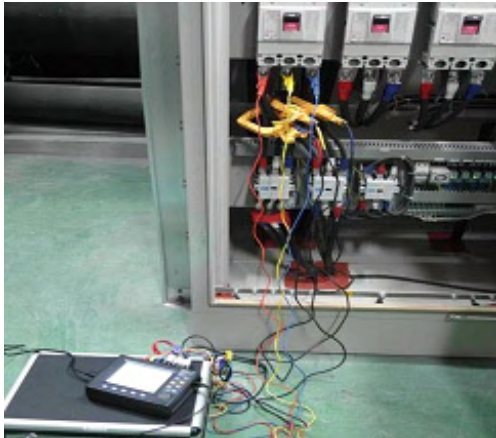
【冷卻水泵電力分析儀安裝】
