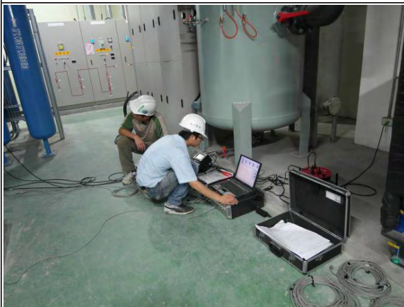
【空調主機測試分析儀架設】
