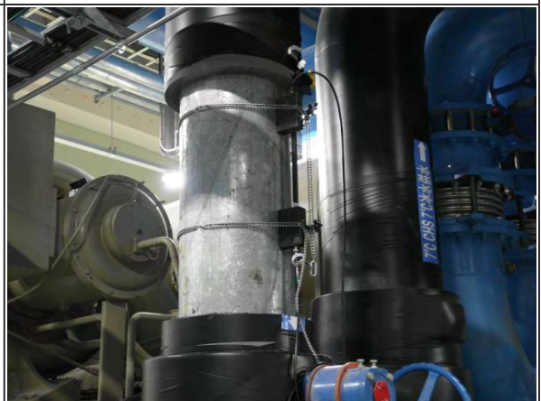
【冰水泵超音波流量計安裝】
