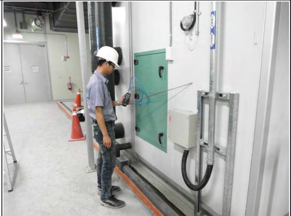
【空調箱吸入端靜壓量測】
