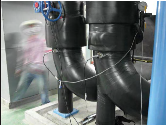
【空調主機冰水出入端溫度計安裝】
