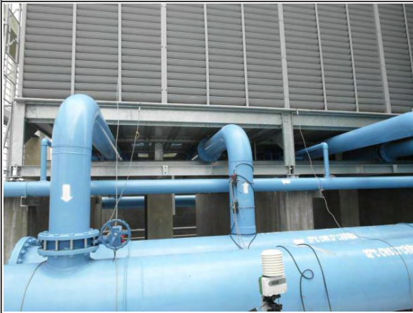
【冷卻水塔超音波流量計管路1安裝】
