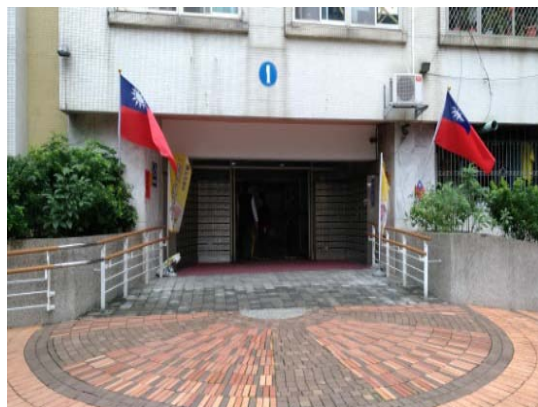
中正國宅入口及居民公共活動空間
