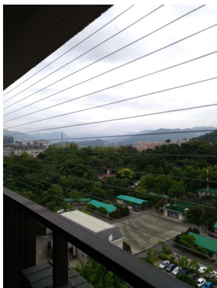
陽台設置防護設施
