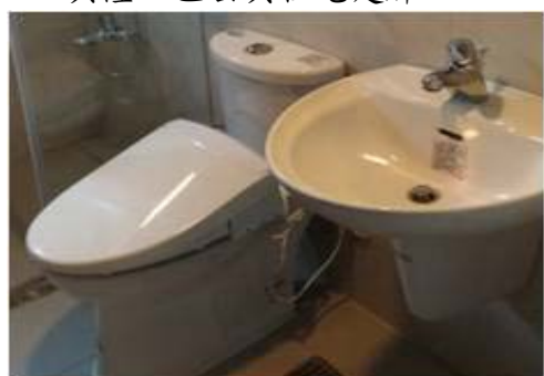
興隆二區公共住宅室內浴室
