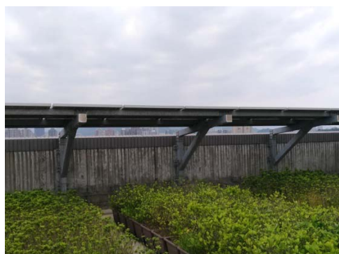
屋頂架設太陽能板
