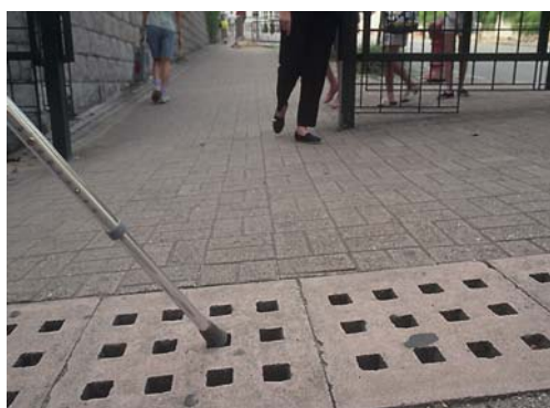
圖 2-2.5 格柵開口過大影響使用例
