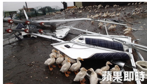
太陽能板飛到 100 公尺外另一處鴨場。
