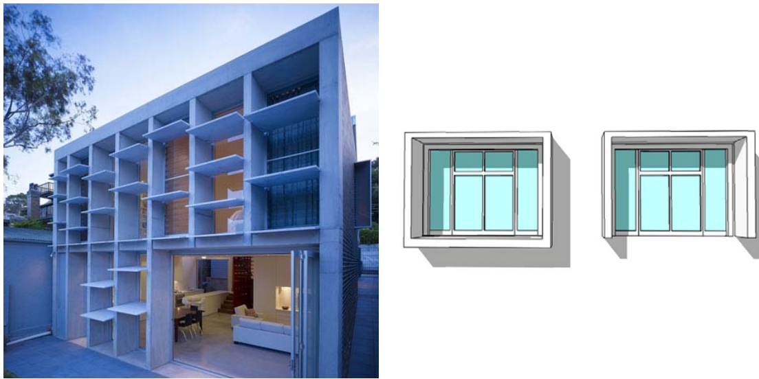
圖 3-42 框架(水平+垂直)遮陽案例及示意圖
