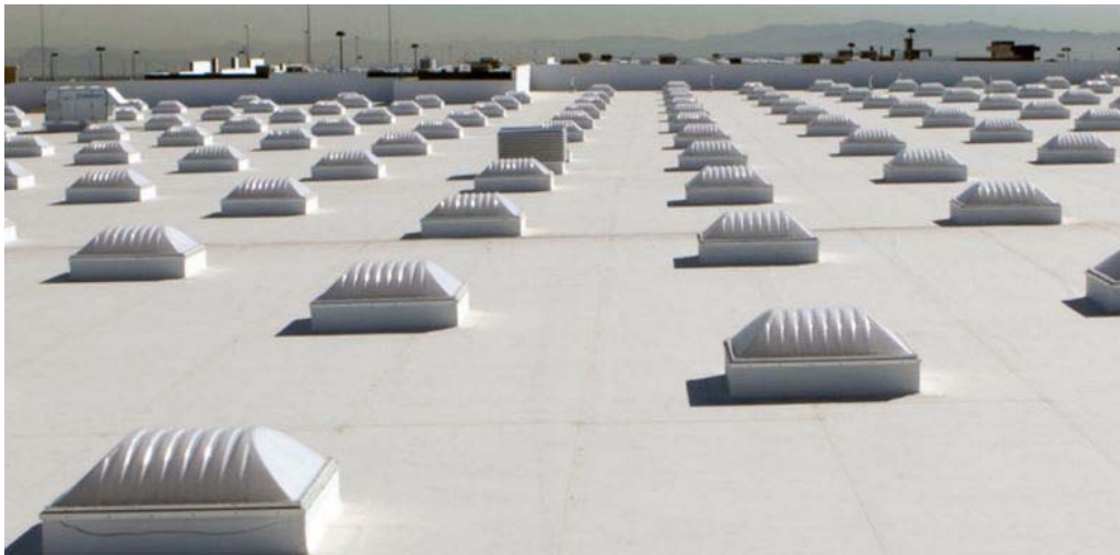
圖 3-38 屋頂鋪設冷屋頂材料案例
