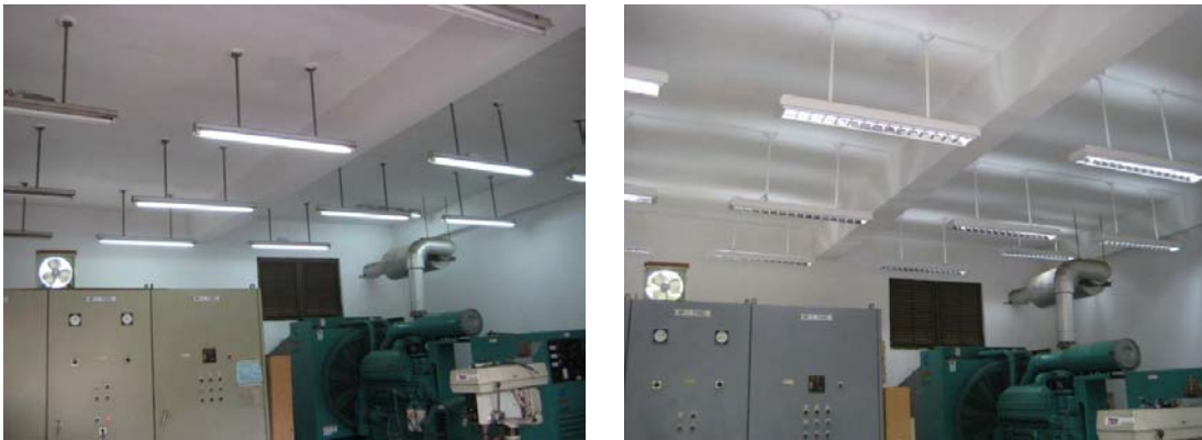
圖 3-29 高效率燈具取代舊有燈具
