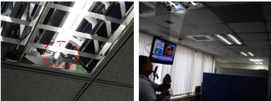
圖 3-33 增設周邊節能輔助設施
