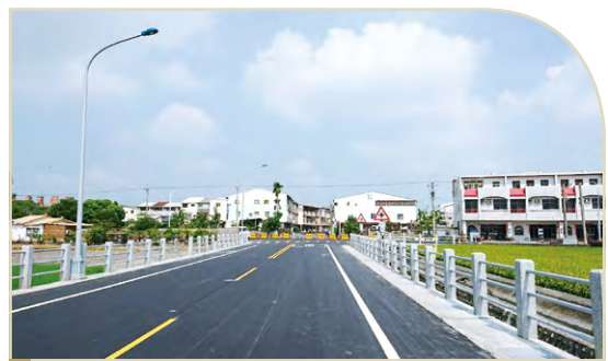
辦理雲林縣荊桐鄉道路開闢工程
