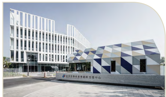
首屆優良智慧建築得獎作品－經濟部傳統產業創新加值中心（二期廠房-A棟）
