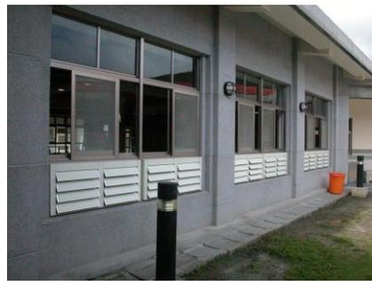
圖 4-2 誘導式自然通風設計示意圖與水平導風板通風設計之設置
