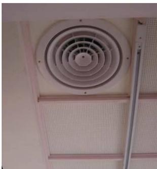
(3) 更換開孔石膏板，增加吸音力
