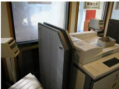
(1) 影印機側裝設吸音隔板
