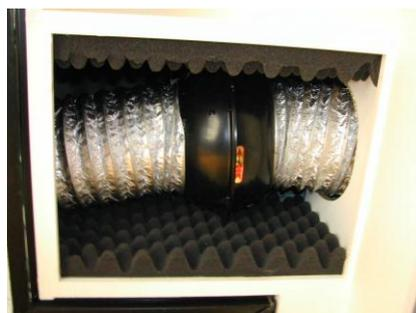
(2) 外氣引入風扇處設置吸音材
