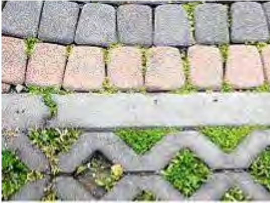
圖 7-15 單元透水磚透水鋪面
