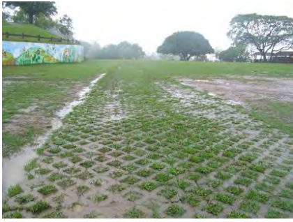
圖 7-5 高性能透水鋪面
