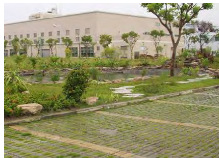
圖 7-13 高性能透水鋪面
