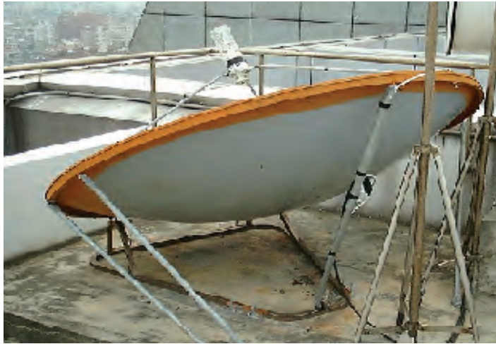
圖 2-2-7 衛星直播電視服務設置之實例 (圖片來源：溫琇玲)
