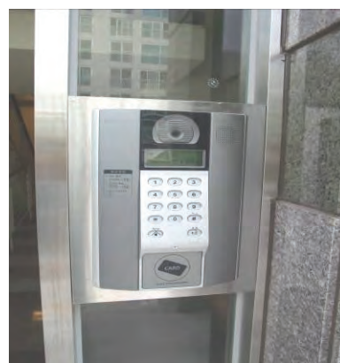
圖 1-4-5 透過影音對講設備進行門禁管制 (圖片來源：簡賢文)
