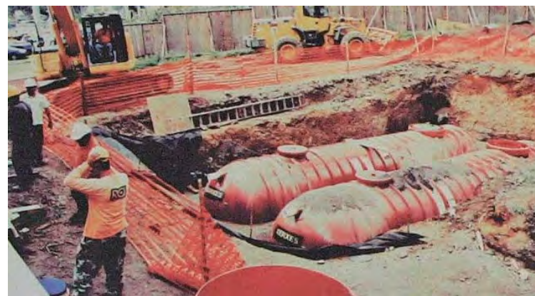
校園興建時便預先埋設一個容量12,000加侖的貯水槽
