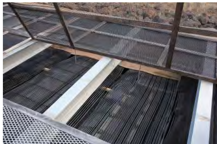
當冰冷的海水送達這棟建築物後，海水通過多層且密集的細小水管，讓空氣通過時可以達到降溫的效果
