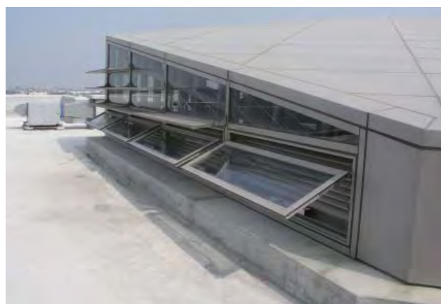
中庭上方之採光通風塔可控制啟閉
