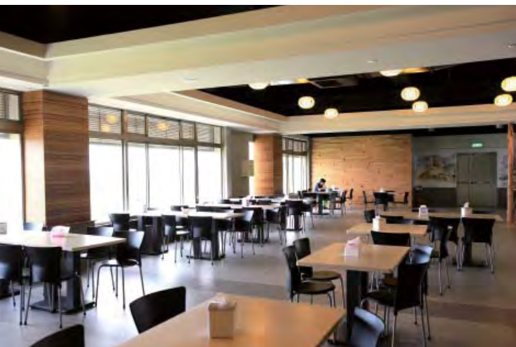
餐廳的裝修材料採用低甲醛的環保油漆粉刷，並採用建築回收廢棄物製成的礦纖板作為天花板材料
