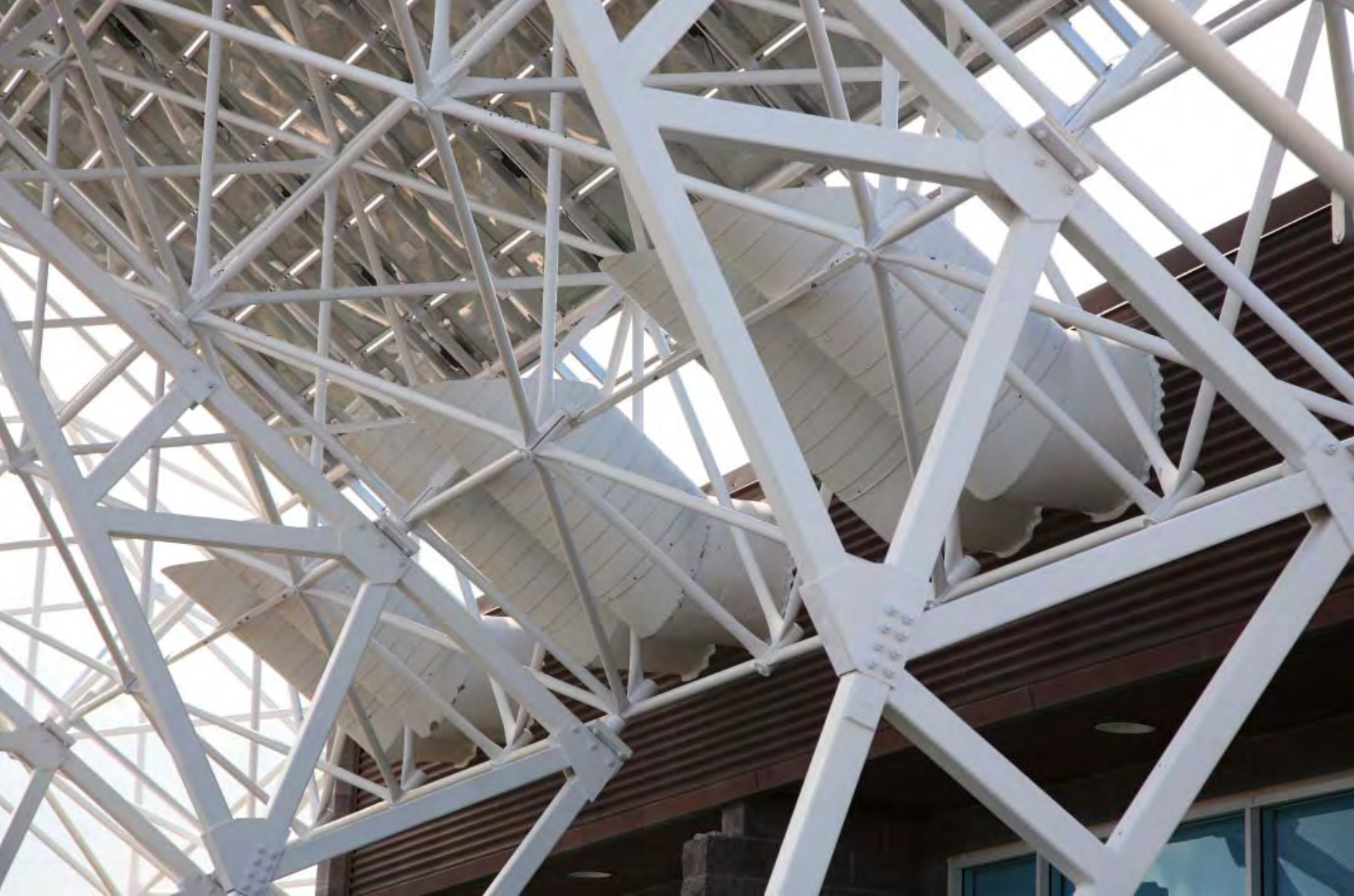
當空氣被加熱後會往上升，從天花板的縫細進入後由建築周圍的14個煙囪排出
