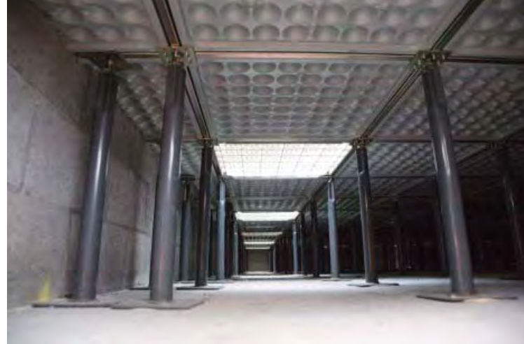
高架地板下經海水冷卻過的涼爽空氣就會吸入充滿整個教室或研究室
