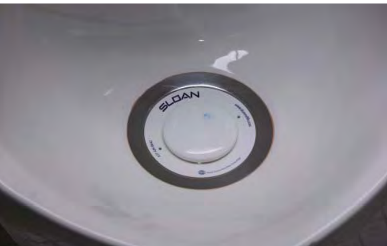
小便斗的排水孔處內部利用特殊可分解的液體封住逸散的臭味
