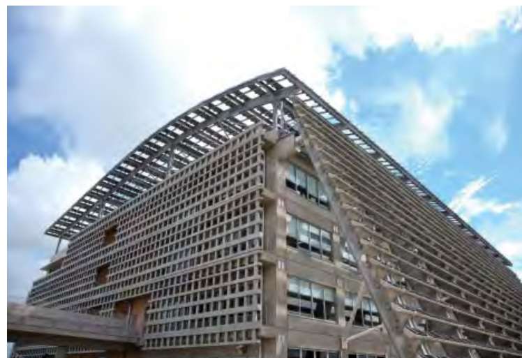
建築物傾斜裝設光電板的目的是避免下方的光電板被上方的光電板阻擋，以求得最佳的發電效率
