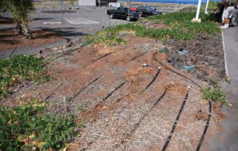
水管表面凝結滴下的冷凝水，做為澆灌庭園與室內的衛生器具用水
