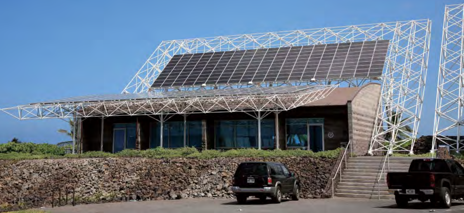
屋頂外架設了20千瓦的太陽能光電系統，充分利用了當地高日照率的優勢，平均每年可提供約24,455度的電力
