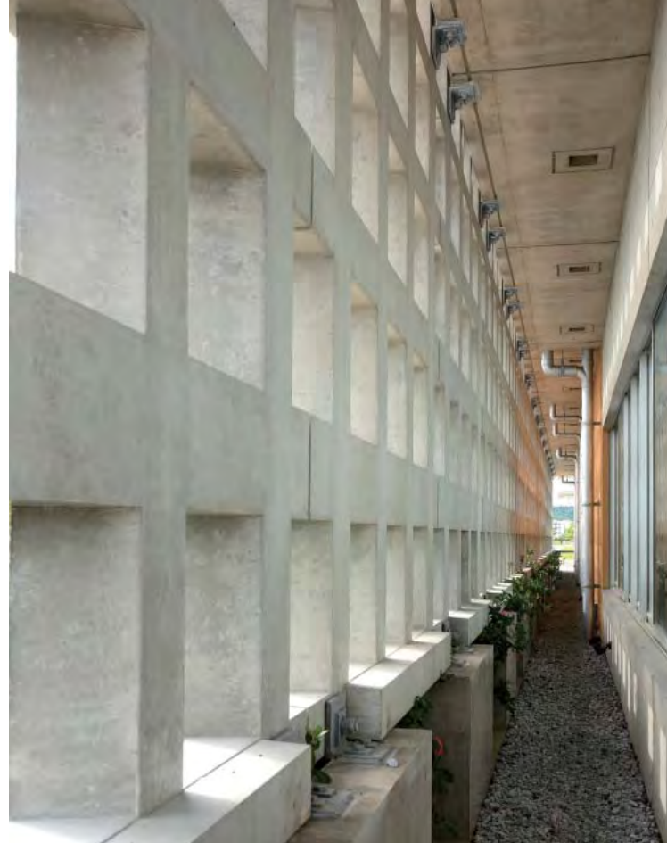
遮陽板與窗戶保留一段距離，可以保持空氣流通達到更好的隔熱效果
