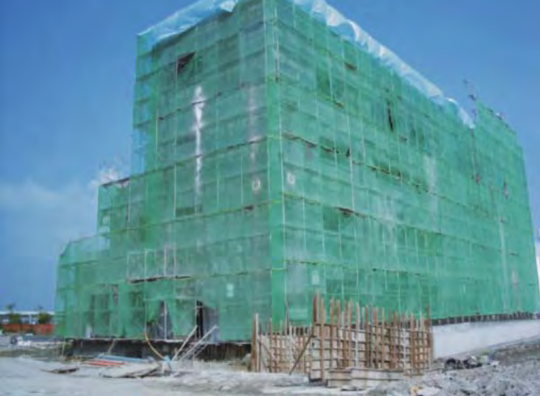
施工時設置各種防空污設施
