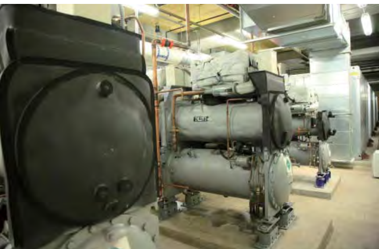
採用夜間較便宜電價製冰的儲冰式空調系統
