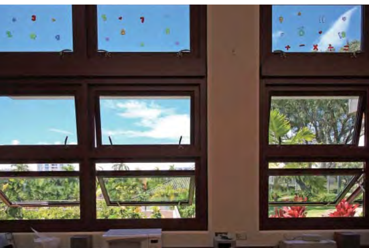
每間教室均有外推窗，同時全面採用高性能的Low-E玻璃
