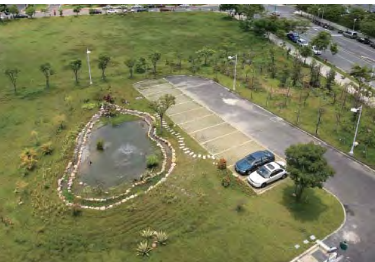
半滲透的生態水池，在暴雨時可匯集周圍雨水，擔任生態滯洪池的功能，對防洪與基地保水有很大的貢獻
