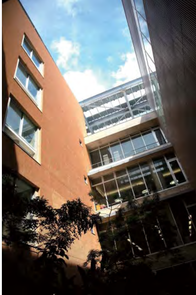
建築師設計了兩處引進自然光的綠化中庭，陽光可從上方的開口投入
