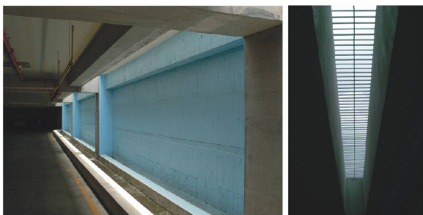
【地下室採光通風天溝設計示意圖】
