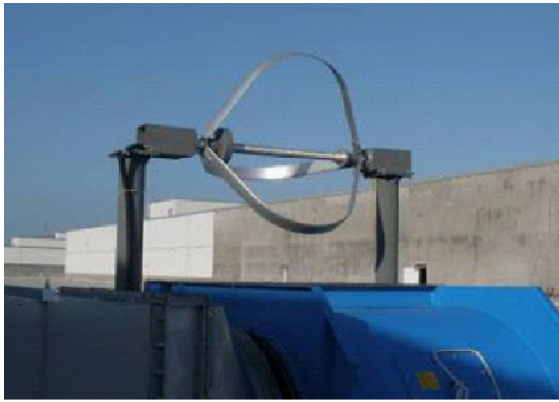
圖2-6.3 氣驅式風力發電系統(一)
