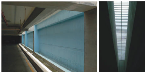
【地下室採光通風天溝設計示意圖】
