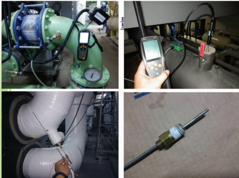
圖2.2 系統儀表比對查核使用測試頭安裝方式
