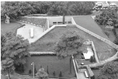
圖1.4 嘉義市二二八紀念館覆土建築與雙層牆通風除濕設計，建議在生物多樣性、日常節能兩指標上可各加2分
