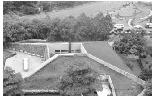
圖1.5 採以工代賑完成的輕鋼構造八八風災重建永久屋，建議在CO 2 減量、廢棄物減量等指標上可被認定為滿分
