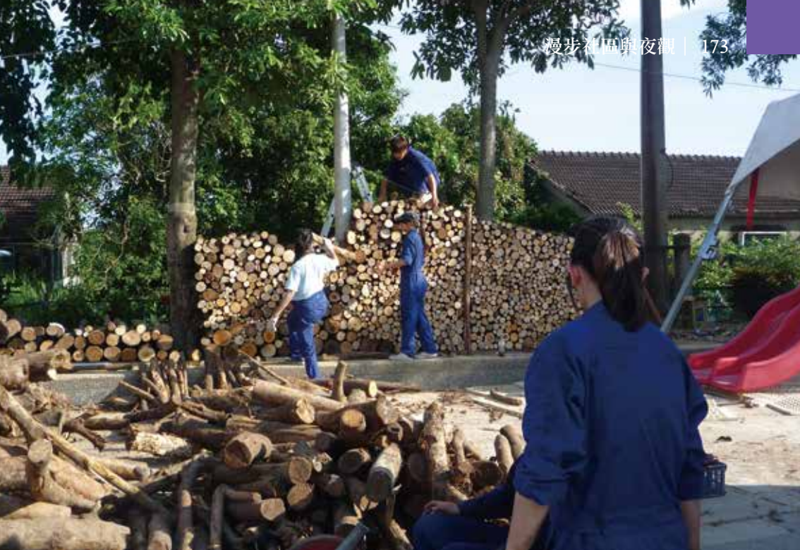
城西社區生態備料庫建造過程
