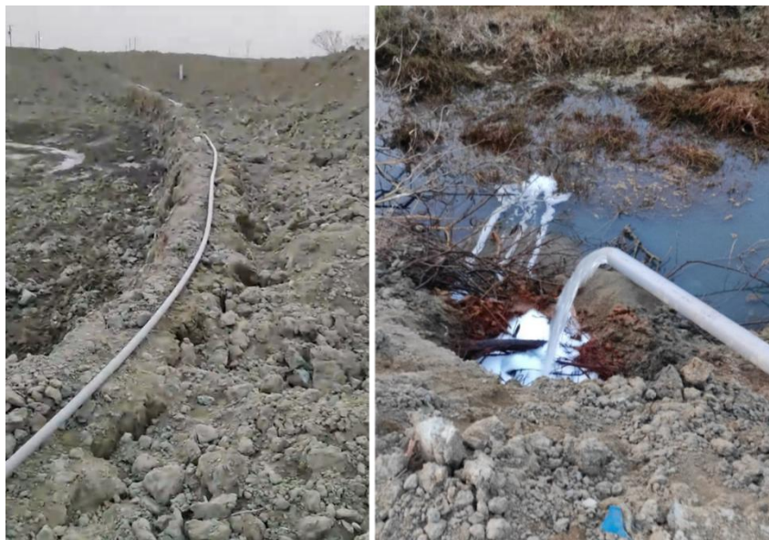
圖 7 光電場施工時之現地抽水照片。
