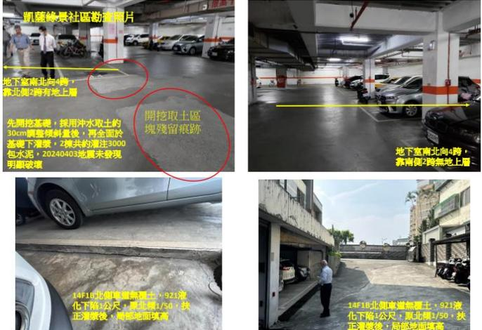
圖 3-14 加州陽光社區 921 地震北側下陷照片 圖 3-15 加州陽光社區 921 後傾斜建物扶正與基礎改良措施情況
