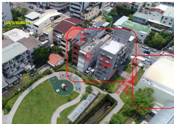
圖 3-55 霧峰中正路菜園溪旁 4 樓地下一層建物液化後傾斜沉陷拆除重建河道改為箱涵
