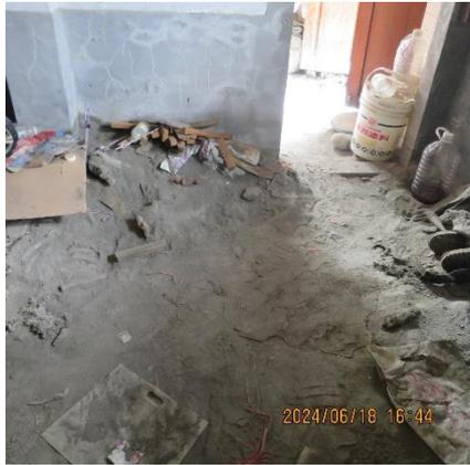
圖 3-65 員水路一段 449 巷 55 號液化噴砂殘留景象
