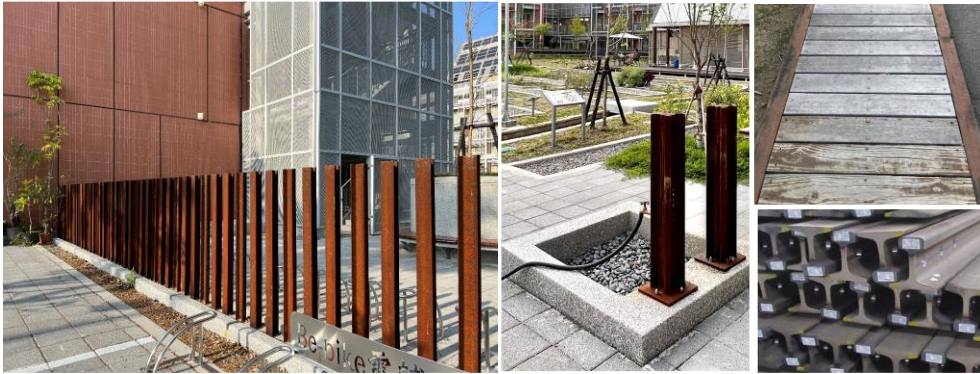
圖 6 台糖沙崙智慧綠能循環住宅舊有運糖鐵道鋼軌替代新設圍籬應用
