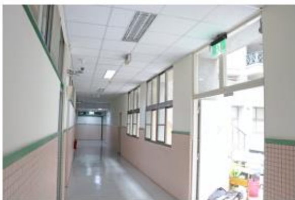
動態導引號誌-出口標示燈安裝位置圖示
