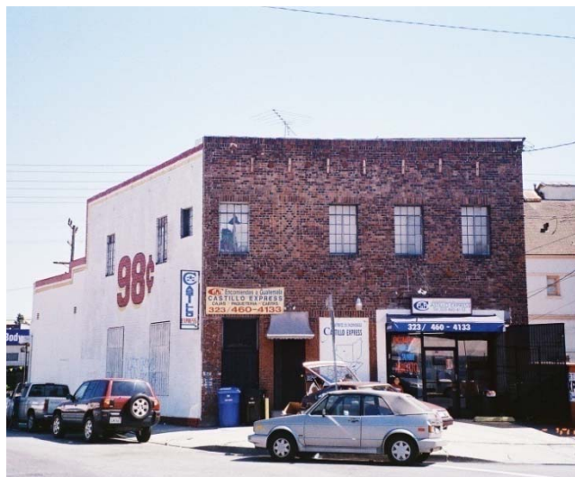
圖 3-14 建築物內部結構(承重牆及樓板)為木構造、外牆為磚構造
