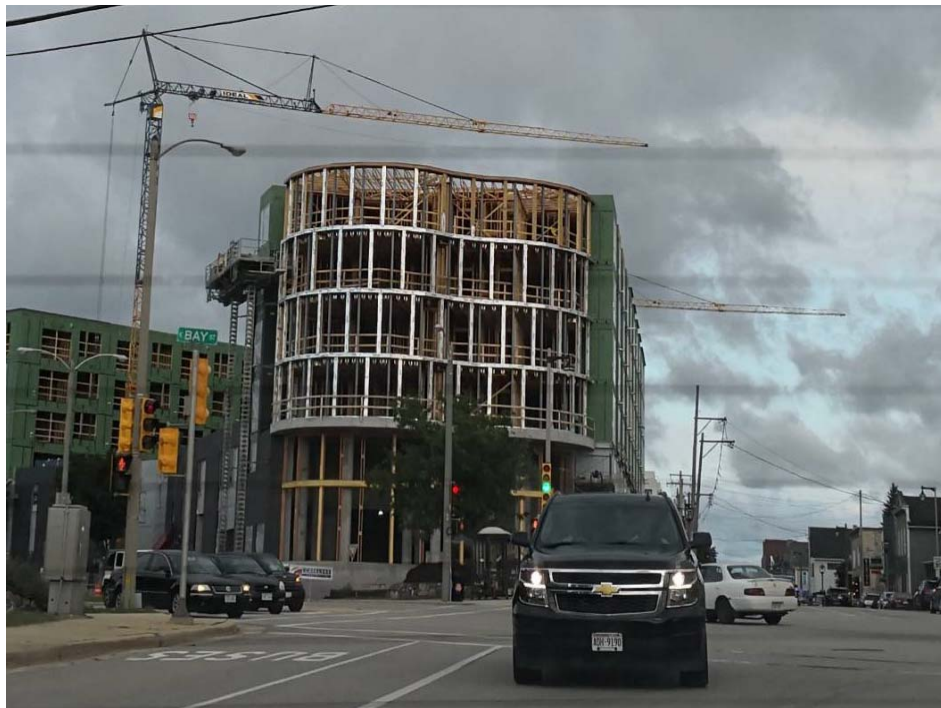
圖 3-13 建築物上層為木構造、下層為鋼筋混凝土結構
